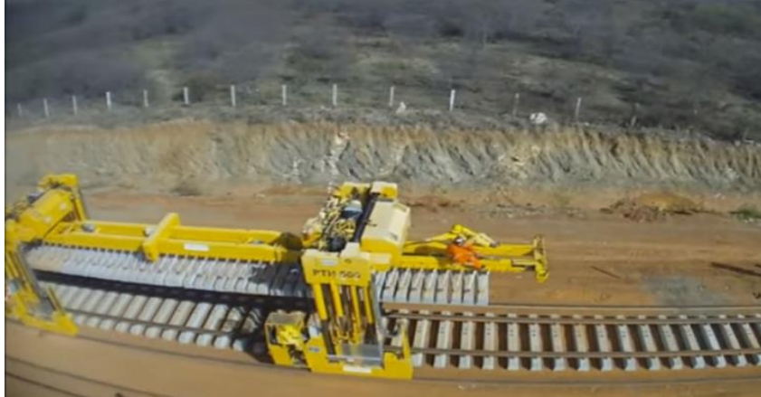
Figura 28 - Montagem das grades (trilhos com dormentes) – posicionamento dos dormentes
