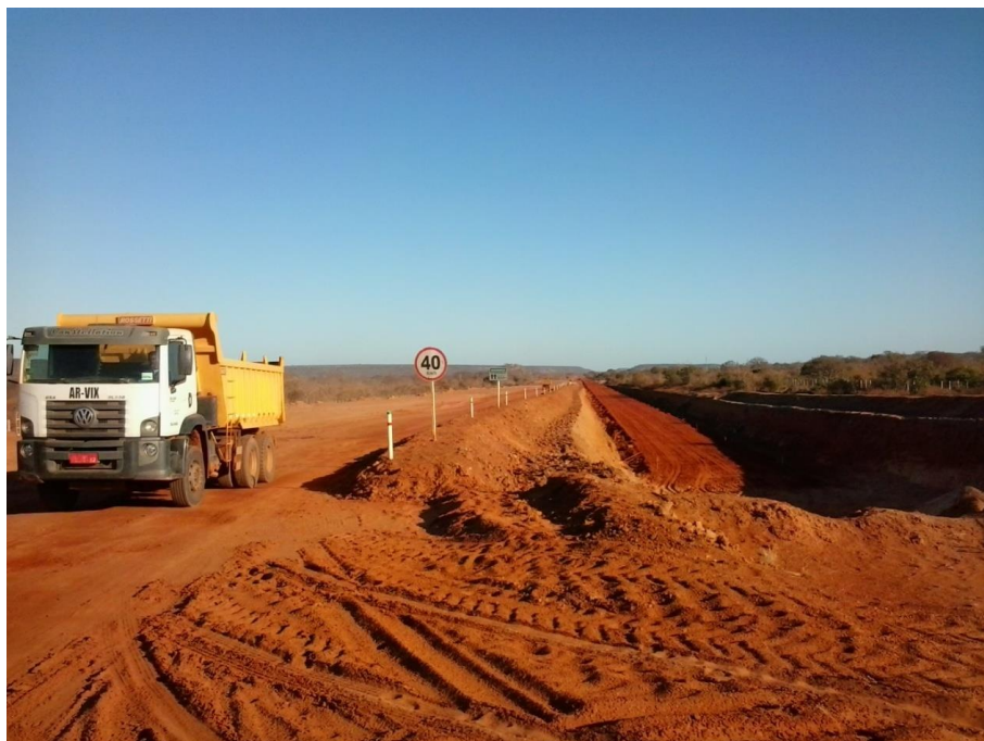
Figura 25 - Construção de passagem da ferrovia Nova Transnordestina, sob a BR-020.
