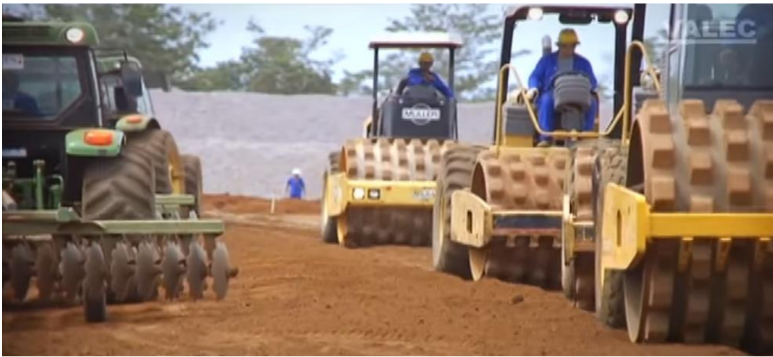
Figura 26 - Compactação do solo em trecho em construção no estado do Piauí
