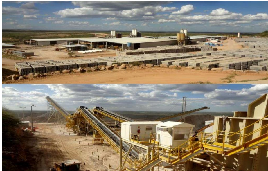
Figura 27 - Canteiro industrial em Salgueiro (PE)
