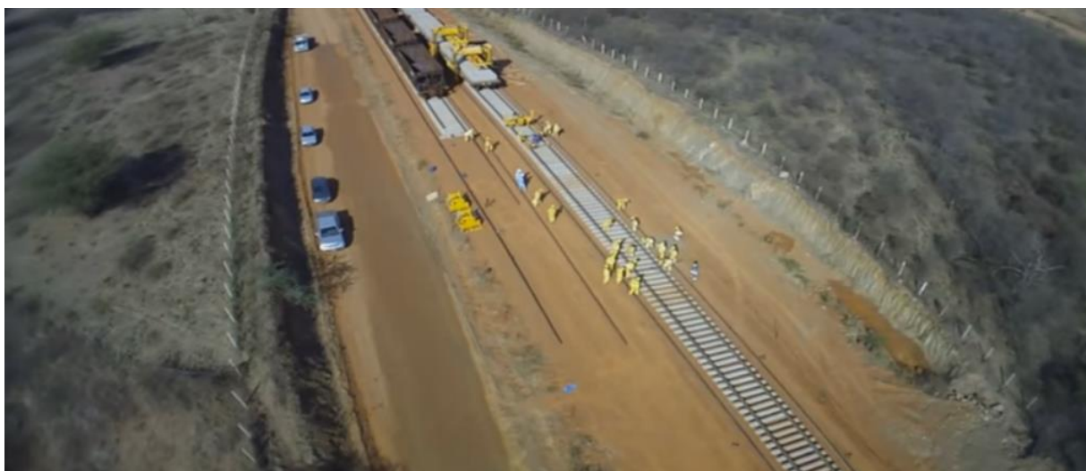
Figura 31 - Montagem das grades (trilhos com dormentes) no local de aplicação.
