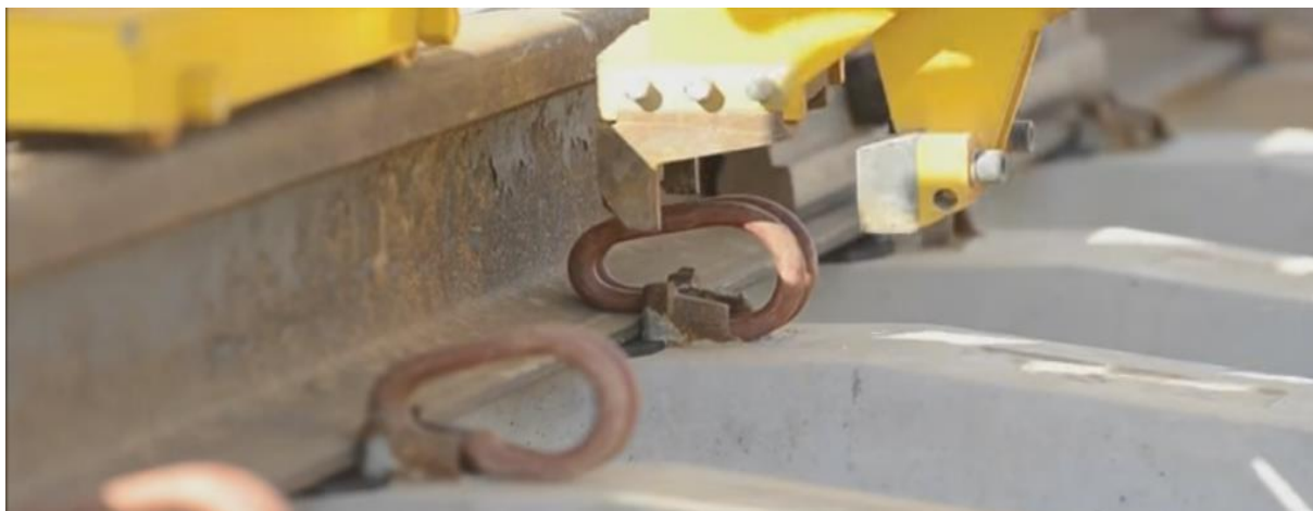
Figura 30 - Montagem das grades (trilhos com dormentes sendo “grampeados”)
