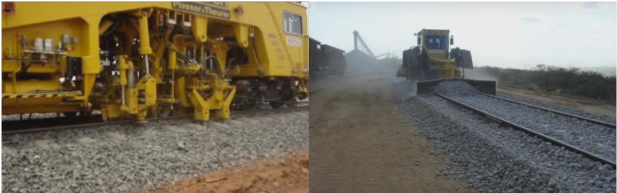
Figura 33 - Compactação do agregado, fixando as grades no solo, retirando-se o excesso.
