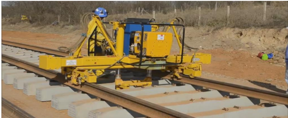
Figura 29 - Montagem das grades (trilhos com dormentes) – posicionamento dos trilhos.
