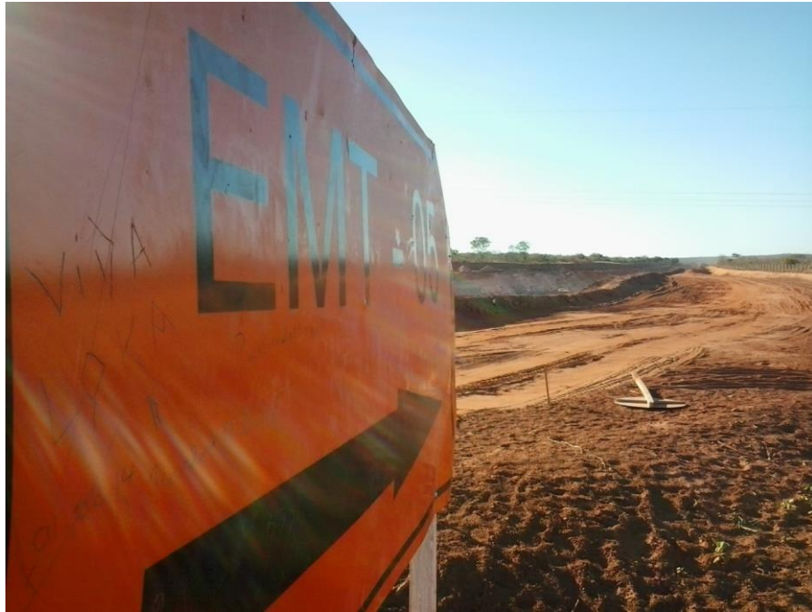
Figura 24 - Construção de passagem da ferrovia Nova Transnordestina, sob a BR-020.
