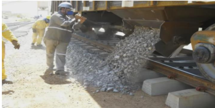
Figura 32 - Aplicação de brita (agregado que sustentará as grades no solo)
