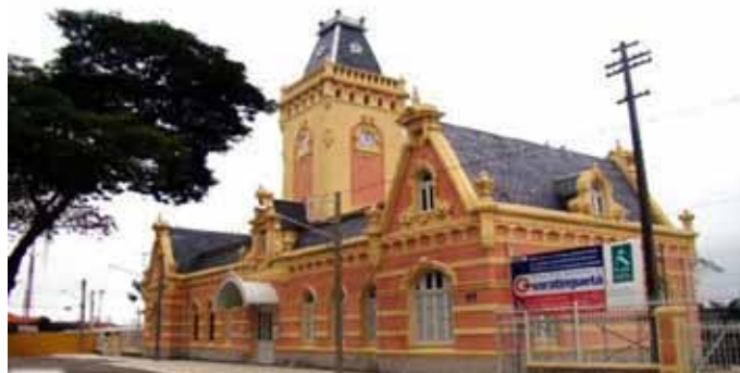
Figura 10. Imagem da Estação após restauro. Fonte: http://www.estacoesferroviarias.com.br/g/guaratingueta.htm .
