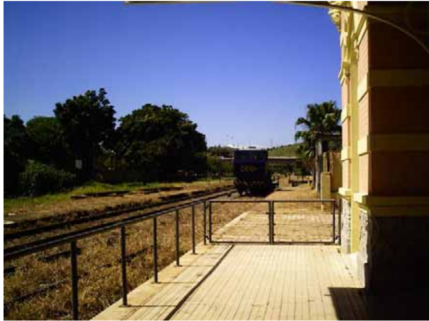
Figura 40. Plataforma da estação. Fonte: Arquivo próprio.
