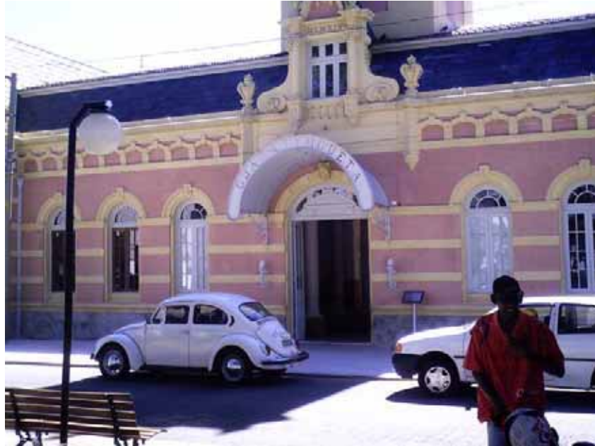
Figura 38. Detalhe da entrada da estação. Fonte: Arquivo próprio.
