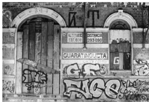
Figura 7. Imagem da Estação no auge de sua degradação. Fonte:
