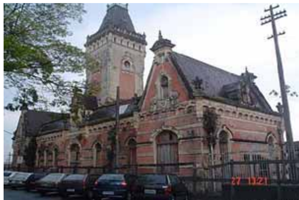
Figura 2. Imagem da Estação em seu estado original. Fonte: http://www.estacoesferroviarias.com.br/g/guaratingueta.htm . Acesso em Mar/09
