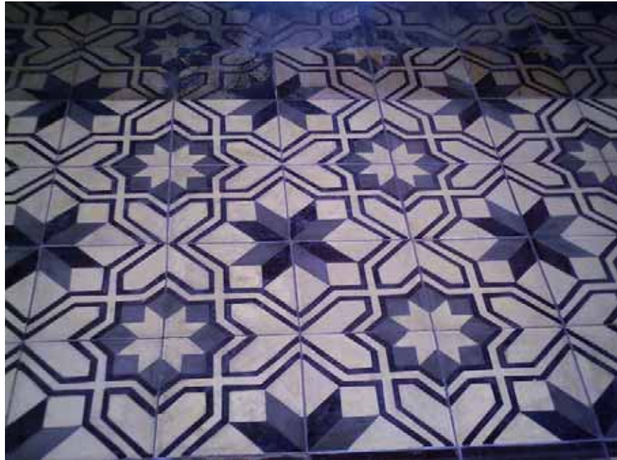
Figura 42. Detalhe do piso de ladrilhos hidráulicos. Fonte: Arquivo próprio.
