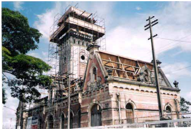
Figura 8. Estação em processo de restauro. Fonte: http://www.estacoesferroviarias.com.br/g/guaratingueta.htm .
