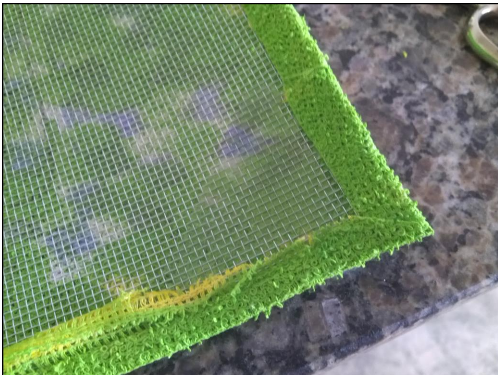
Figura 22 – Detalhe da colagem do pano na rede de alumínio
