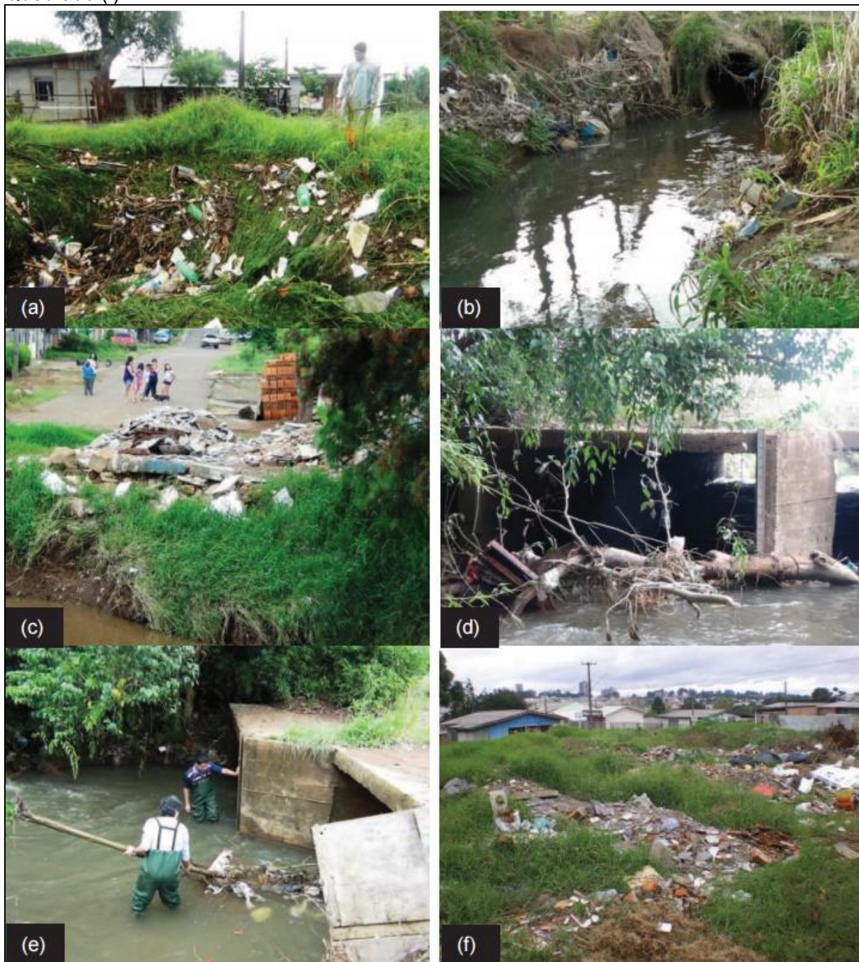
Figura 48. Resíduos acumulados nas margens e nos dutos de canalização em arroios urbanos de Guarapuava: arroio Barro Preto (a,b,c); arroio do Engenho (d,e); arroio Carro Quebrado (f)
