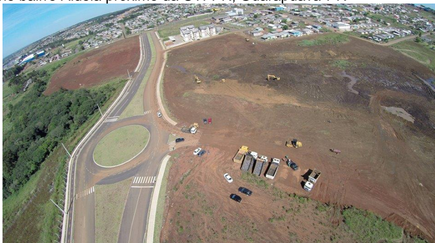
Figura 61. Remoção das áreas turfosas e terraplanagem para construção do lago no arroio Charquinho no bairro Aldeia próximo da UTFPR, Guarapuava-PR
