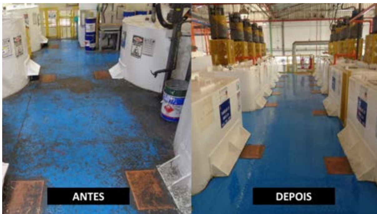
Figura 35 - Evidência da realização de limpeza e re-pintura de área de armazenamento.
