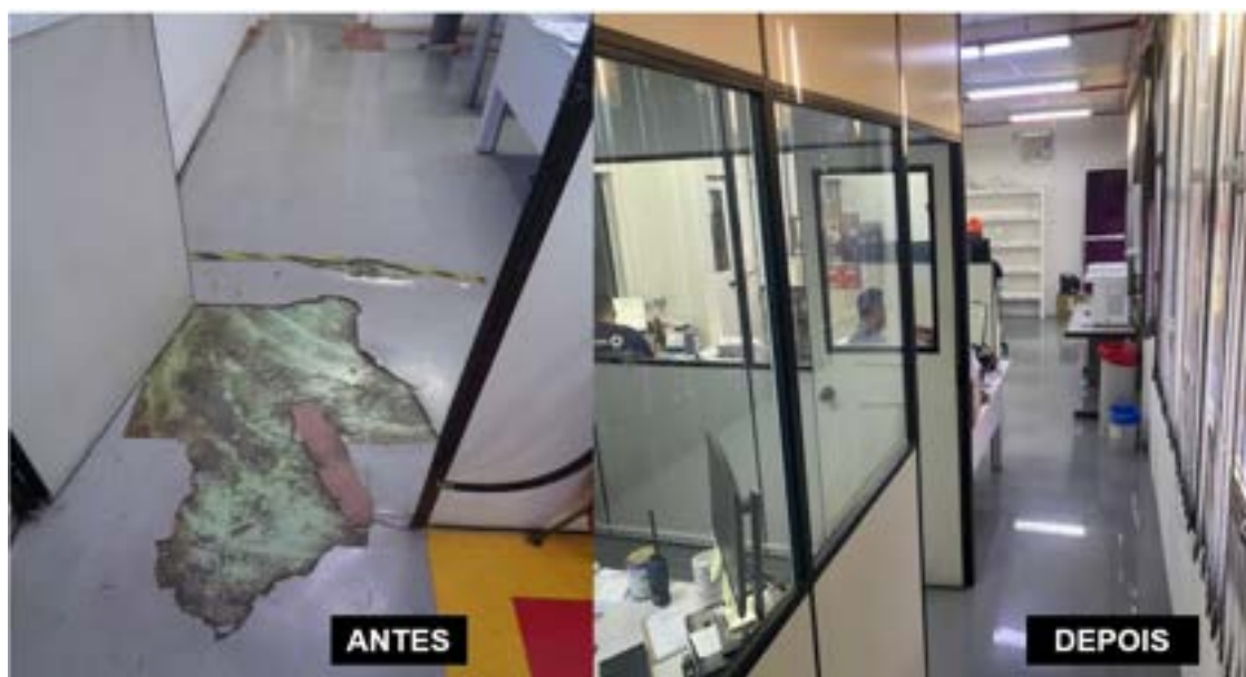
Figura 40 - Antes e depois do chão da sala administrativa da área de envase.
