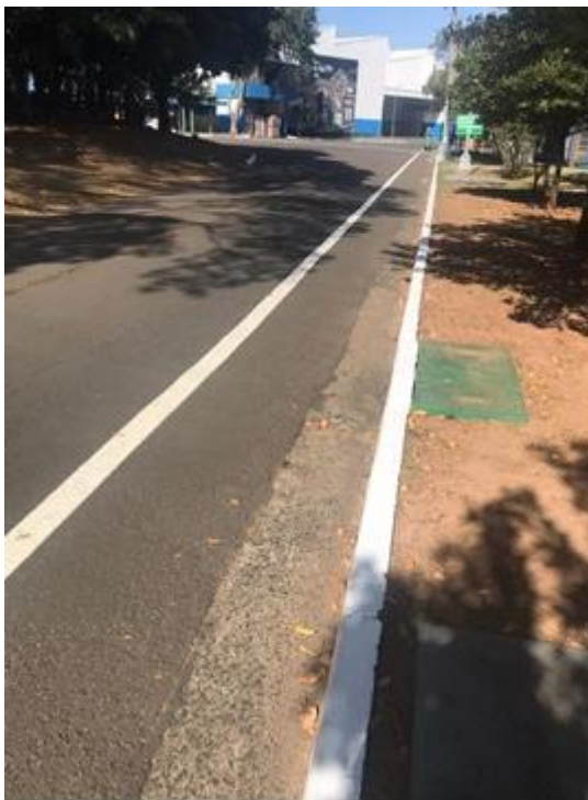
Figura 43 - Manutenção das pinturas de faixa de sinalização e guias da área externa.
