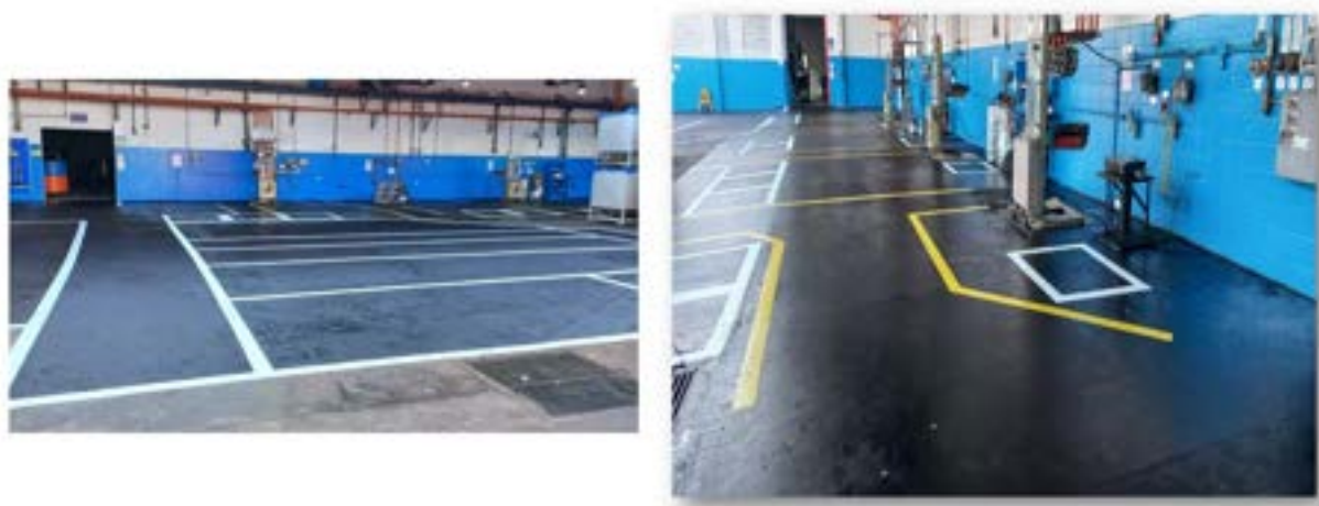
Figura 28 - Evidência de novas marcações de tramitação e de tanques na área externa produtiva.
