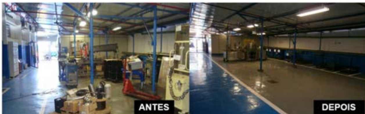
Figura 23 - Antes e depois da área de Manutenção.
