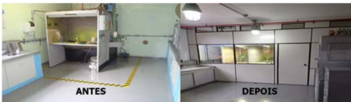
Figura 13 - Antes e depois da implantação de isolamento e sistema de exaustão da cabine de pintura no laboratório.
