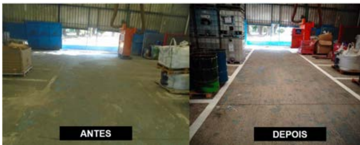
Figura 39 - Antes e depois da área de Processamento de Resíduos.
