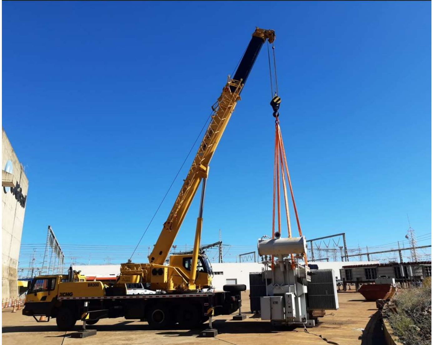
Figura 38 – Operação de Içamento do TRANSFORMADOR REGULADOR CoEmS.a. 7.500 KVA.
