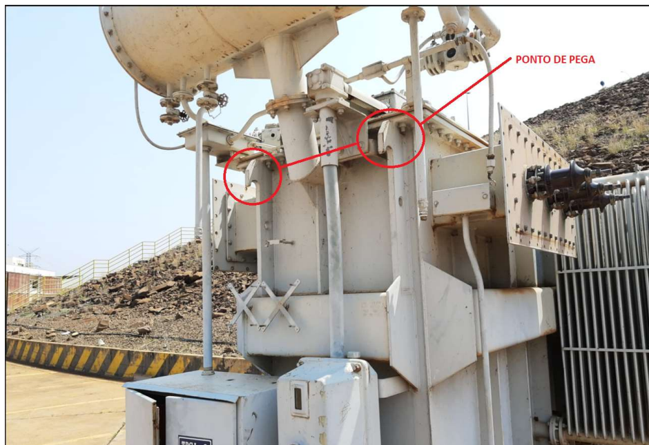
Figura 28 – Pontos de pega do Transformador Regulador -TRSA.
