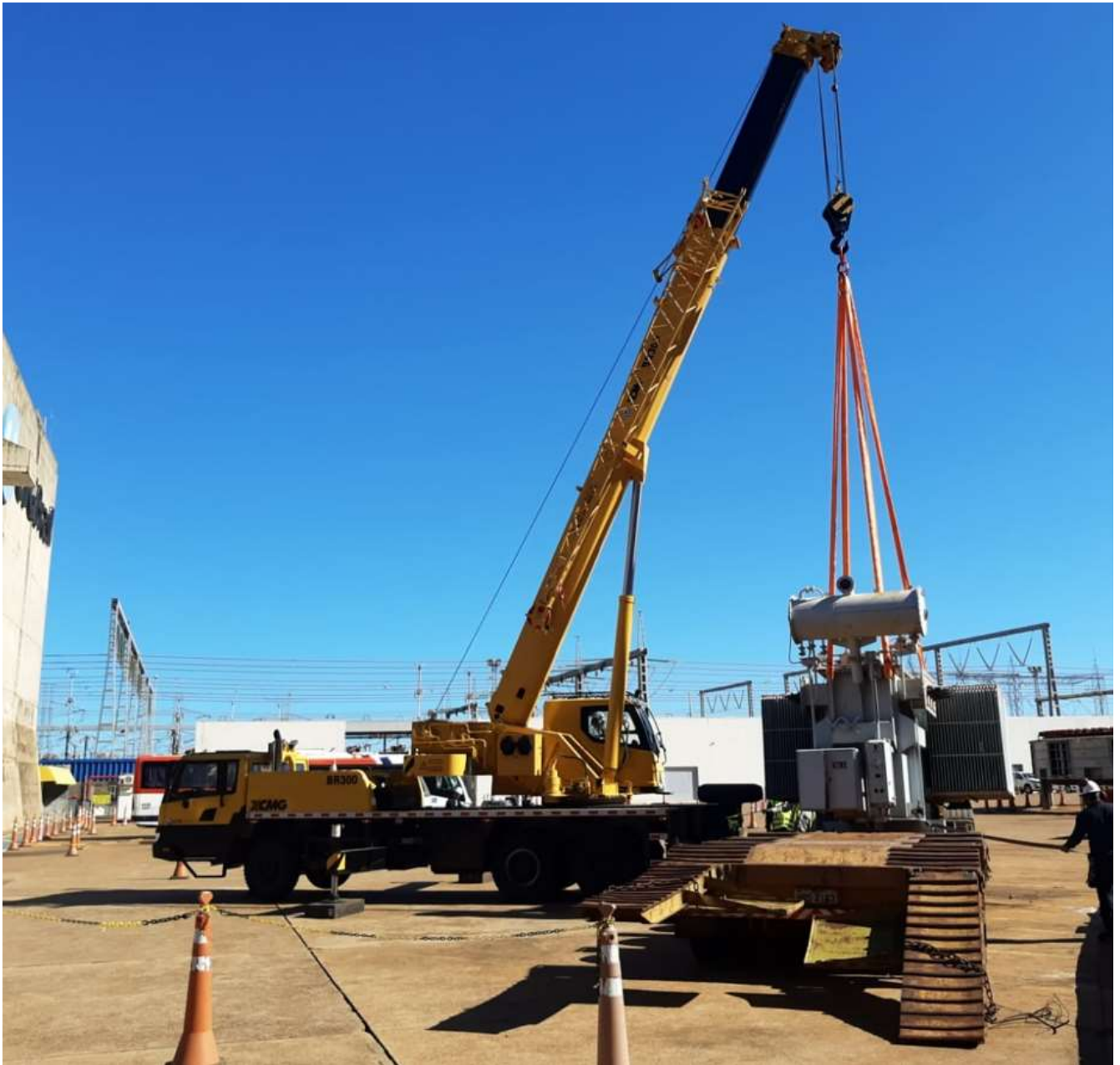
Figura 38 – Operação de içamento do TRANSFORMADOR REGULADOR CoEmS.a. 7.500 KVA.
