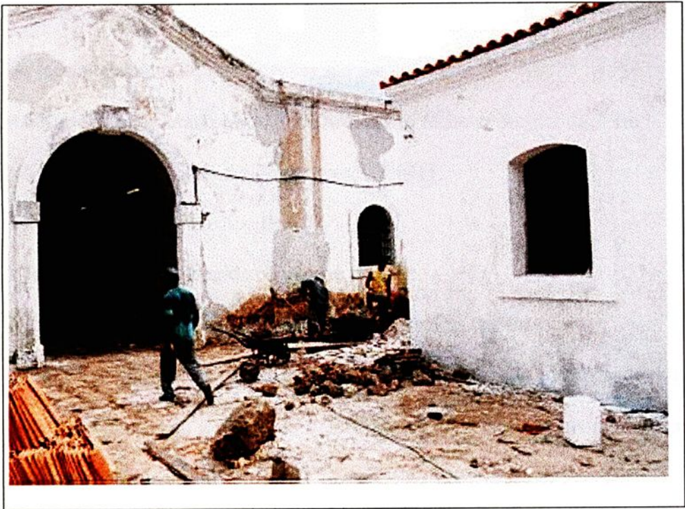
Detalhe da entrada da Casamata
