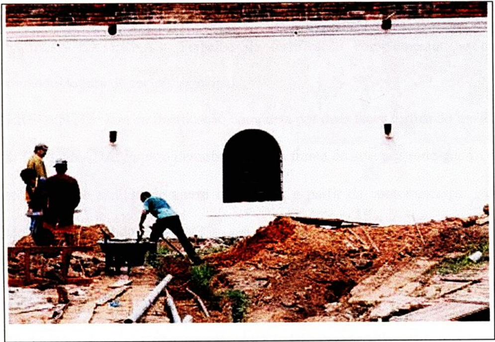
Detalhe da Casamata
