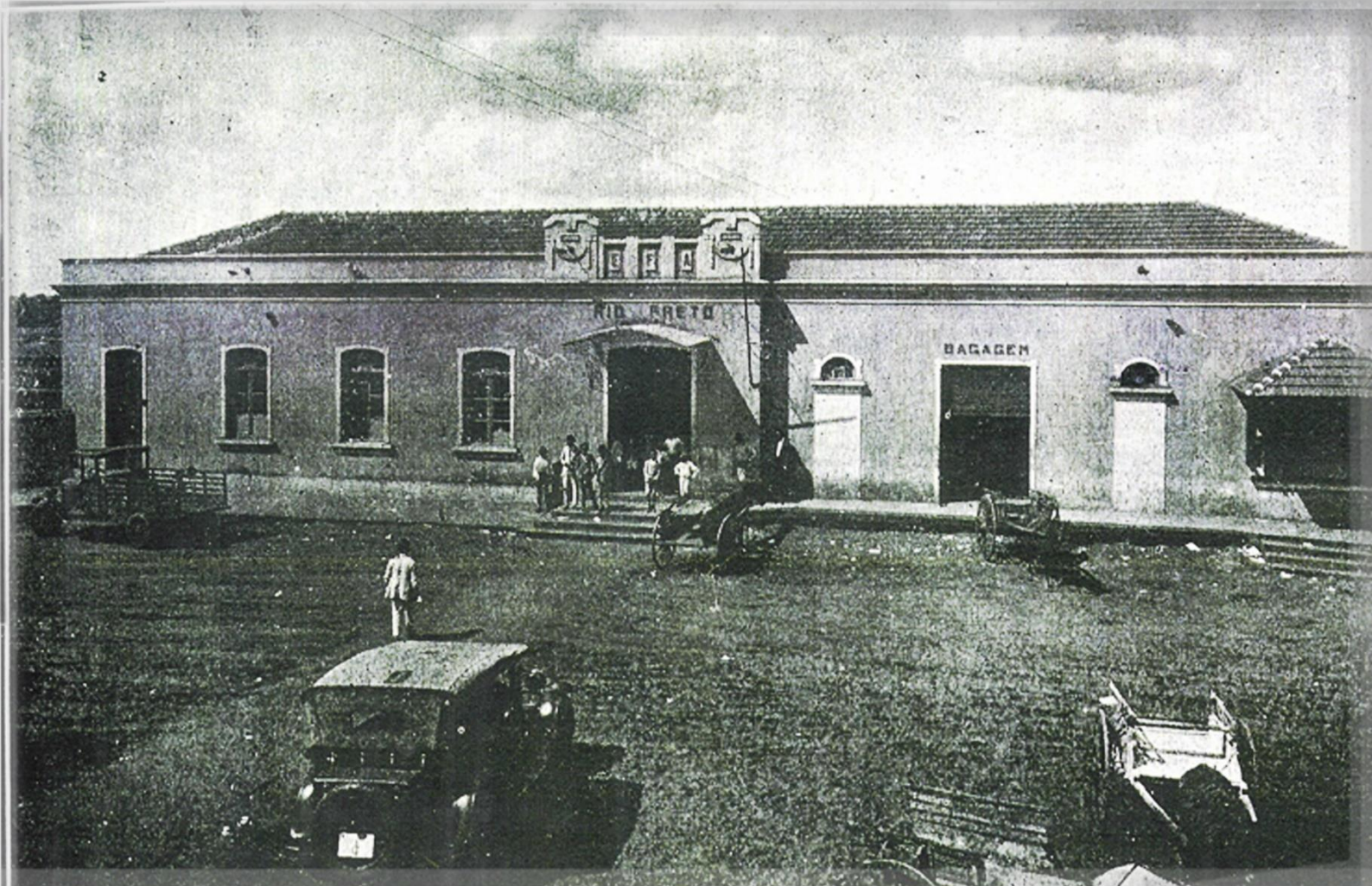
Figura 13 e 14 - Estação Ferroviária construída na década de 1920 e a mesma Estação após passar por uma reforma na fachada.
