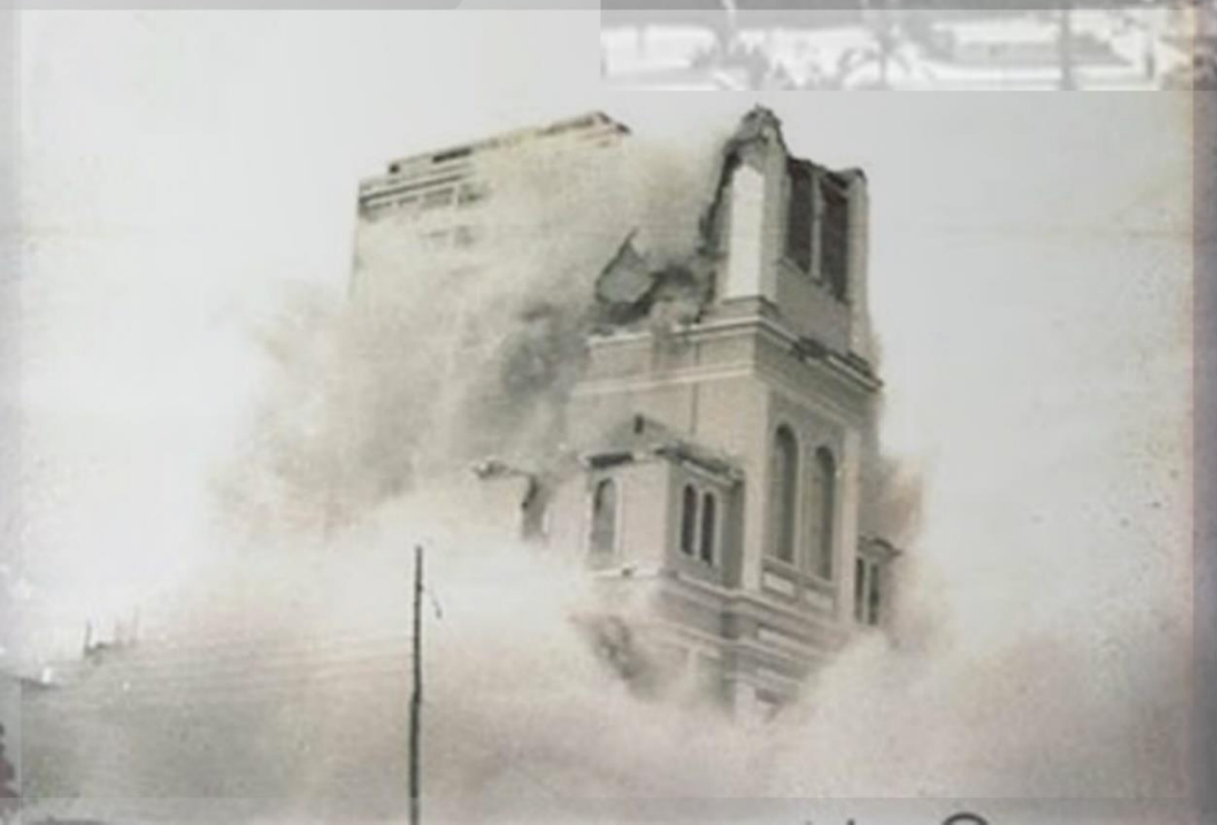
Figura 36 e 37: Catedral de São José na década de 1960 e na década de 1970 sendo demolida. Fonte: Acervo particular de Nilce Lodi.
