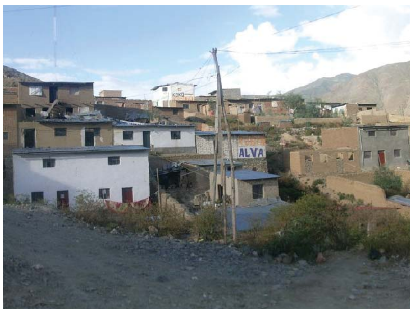
Figura 34: Vista parcial de Futura Generación.
