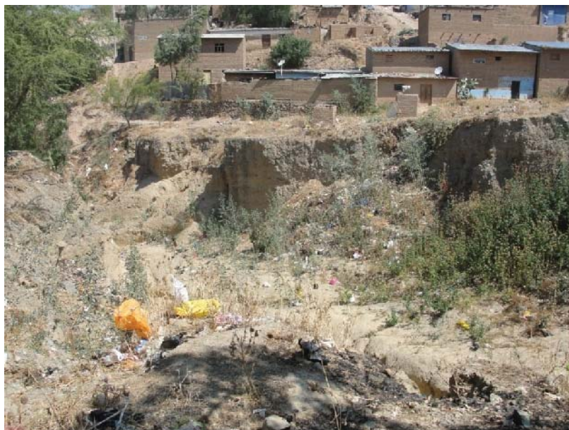
Figura 35: Vista parcial de um huayco em Leoncio Prado.
