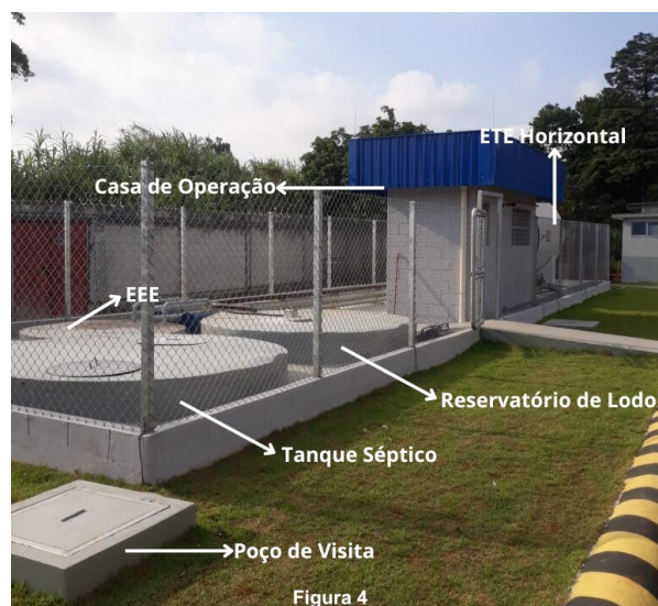
Figuras 3 e 4 - ETE Horizontal sobre a base instalada na COMPANHIA ULTRAGAZ SA em Mauá/SP
