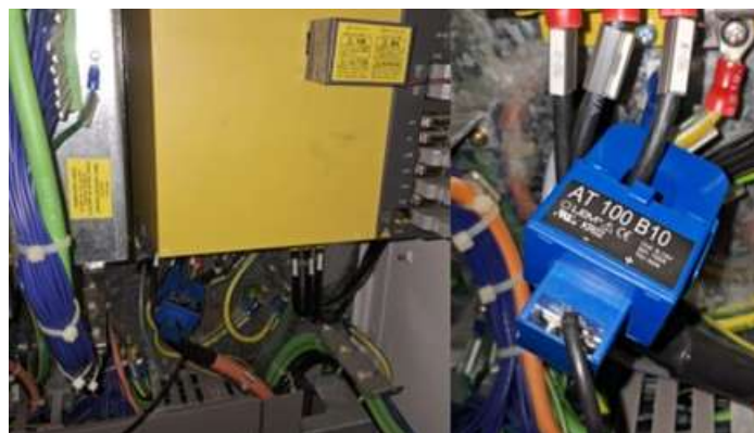
Figura 31 - Sensor de corrente, marca LEM, modelo AT 100 B10
