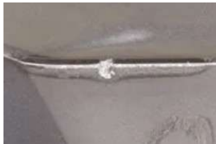
Figura 12 - Exemplo de lascamento.
