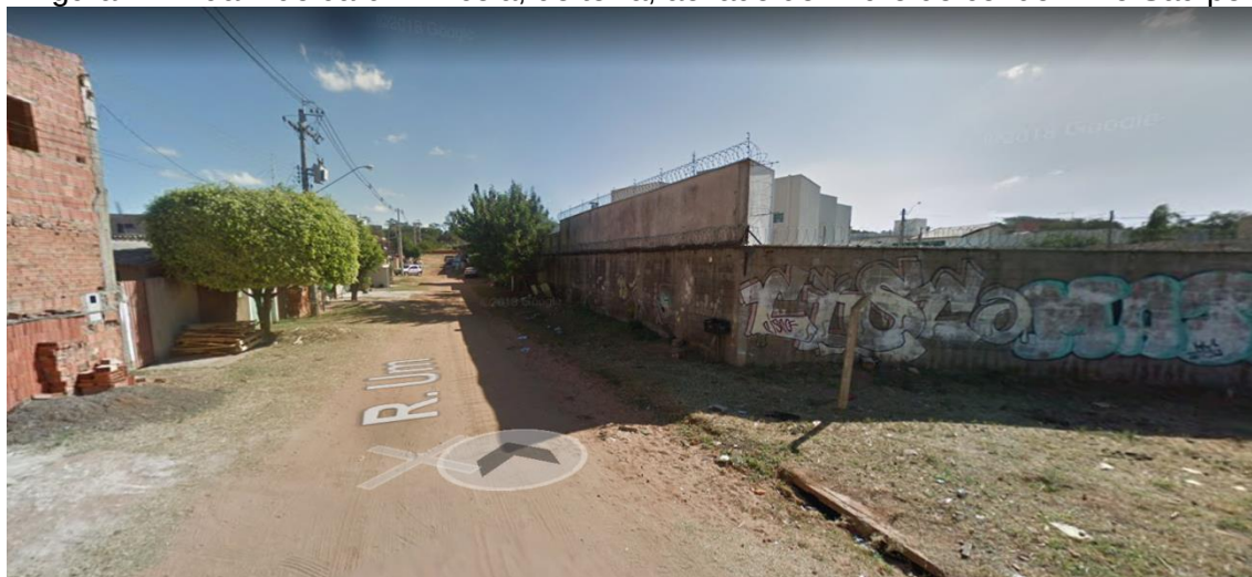
Figura 2 – Rua 1 do Jardim Niceia, de terra, ao lado do muro do condomínio Sauípe
