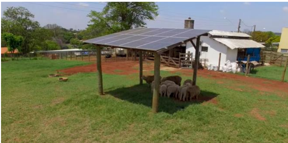
Figura 3 – Foto mostrando ovelhas na sombra projetada pela estrutura de sombreamento feita de madeira e painéis solares fotovoltaicos
