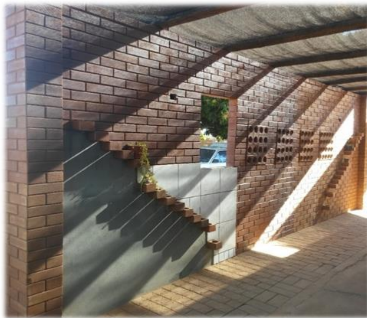
Figura 1 – Construção executada com tijolos de solo-cimento aparente
