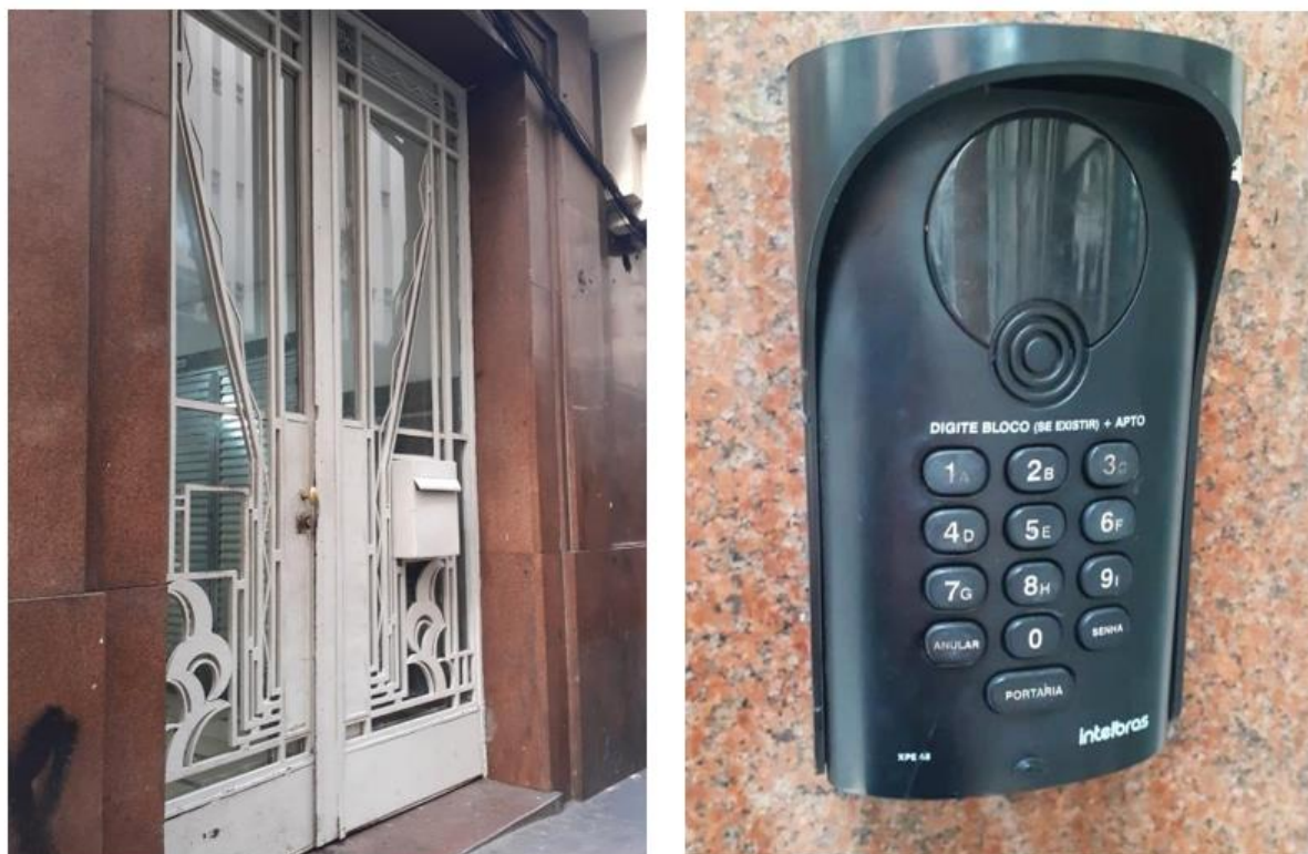
Figura 32 - Itens de segurança do Edifício Senador Feijó
