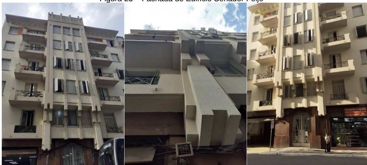
Figura 25 – Fachada do Edifício Senador Feijó
