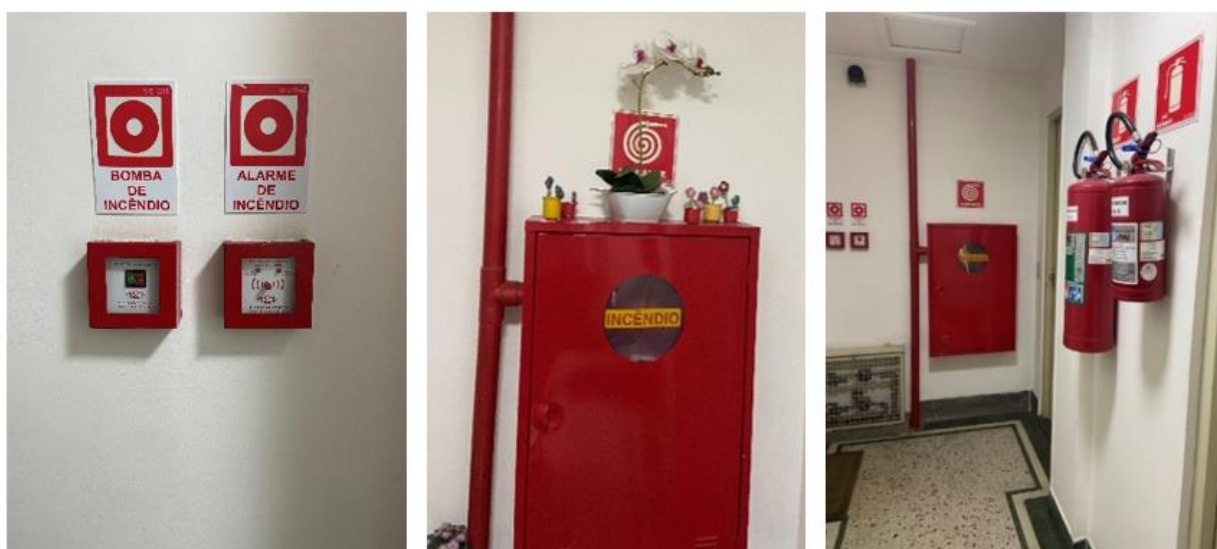
Figura 33 – Itens de segurança do Edifício Senador Feijó
