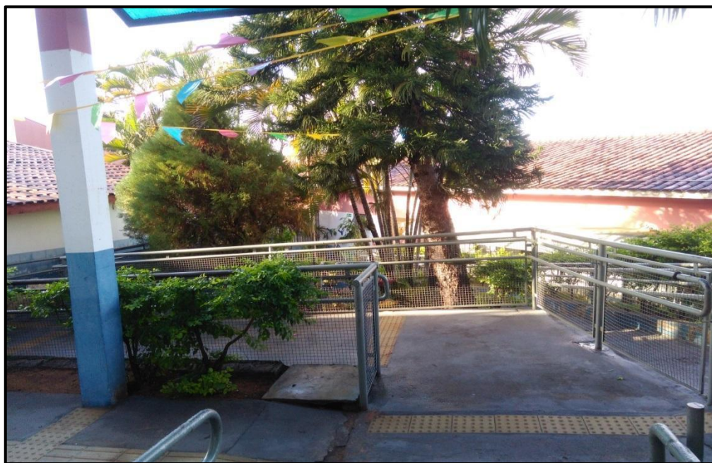
Figura 5 – Rampa de acesso ao pátio e às salas de aula.
