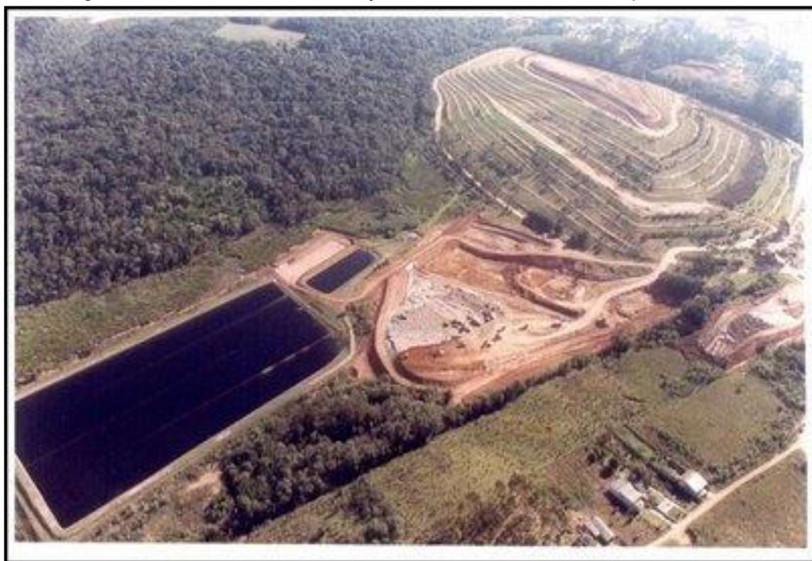
Figura 12 - Aterro sanitário: Destinação de resíduos sólidos sem impacto ambiental
