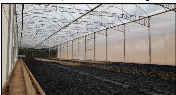
Figura 74 - Disposição do lodo em duas baias, de 81m de comprimento e 12,8m de largura
