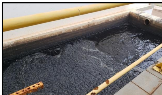
Figura 69 - Lodo recebido da ETE para centrifugação
