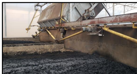
Figura 73 - Processo mecanizado de revolvimento do lodo de esgoto
