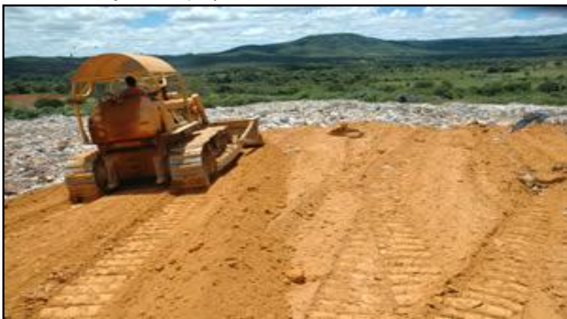
Figura 11 - Disposição de resíduos sólidos em aterro controlado
