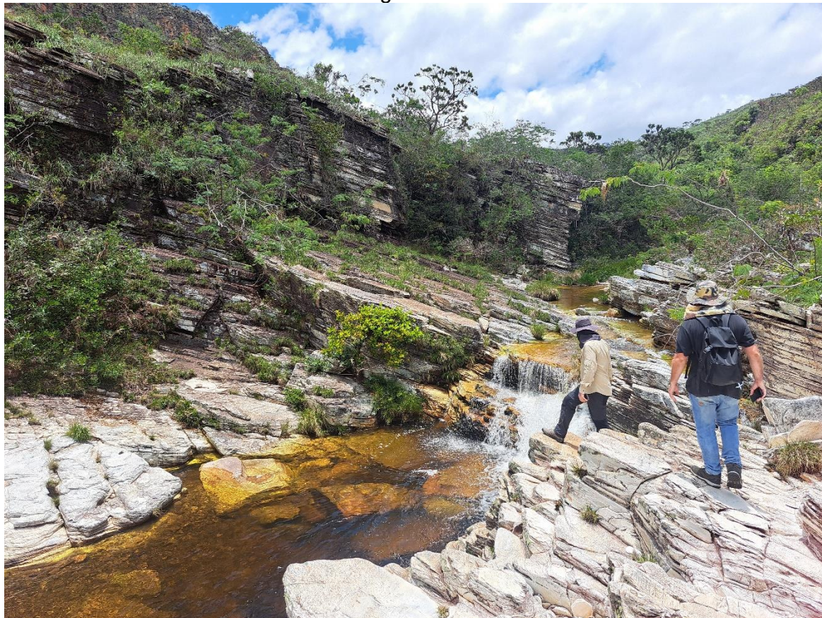
Figura 37: Talude rochoso na margem sul do Ribeirão da Capivara evidenciando descontinuidades com mergulho favorável à face da encosta.
