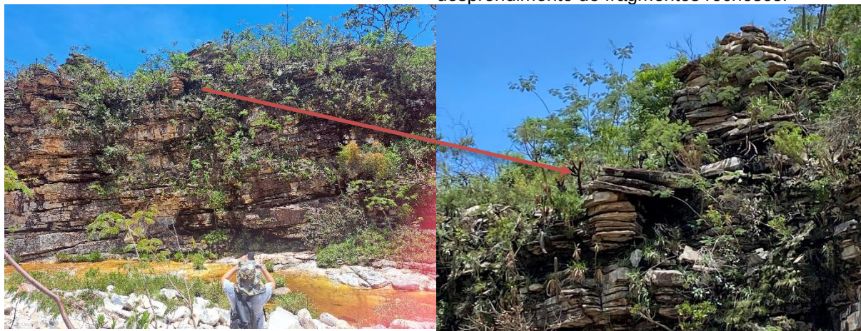
Figura 33: Detalhe da crista do talude do setor RC-07, evidenciando blocos tabulares soltos e empilhados, indicando compartimentação estrutural do maciço e potencial para desprendimento de fragmentos rochosos.
