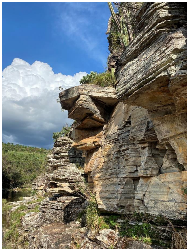
Figura 15: Detalhe do maciço rochoso evidenciando camadas de quartzito intensamente fraturadas, com blocos tabulares projetados e parcialmente individualizados por descontinuidades, formando volumes em balanço. Observam-se ainda cicatrizes de desprendimentos pretéritos associadas ao Sn sub-horizontal.
