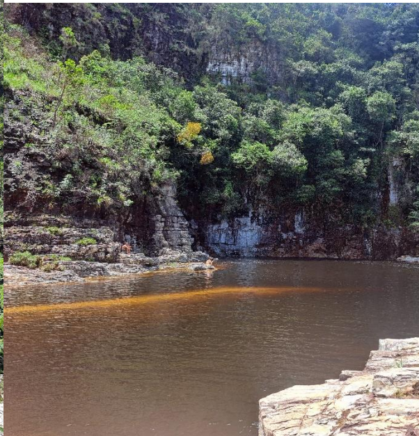
Figura 28: Turista no sopé do talude rochoso, evidenciando a área de permanência de visitantes. Na crista observam-se blocos tabulares soltos potencialmente suscetíveis a desprendimento.
