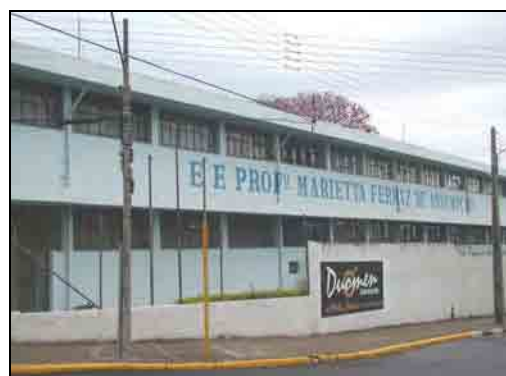
Figura 3.2: Fachada da U.E
