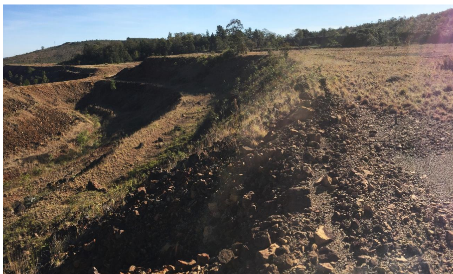
Figura 8 - Patamares superior e inferior da pilha de estéreis BF-8.
