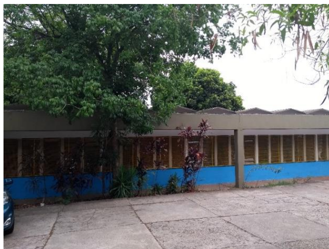
IMAGEM 3: Visão das salas de aula na área do estacionamento
