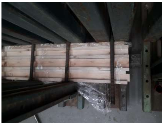
Figura 35 – Vigas posicionadas na prensa
