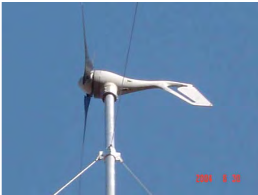
Figura 9. Aerogerador AIR-X com potência nominal de 400W, instalado no sistema híbrido.
