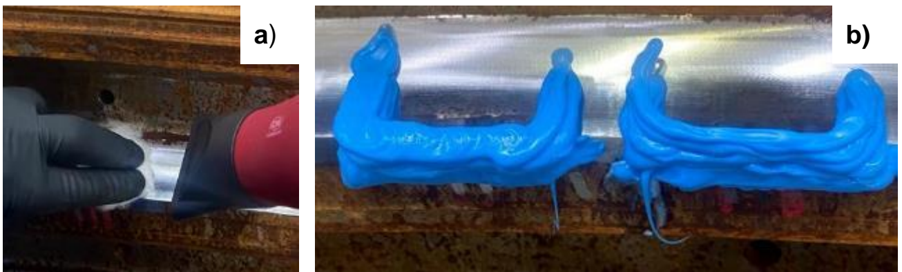
Figura 23 - Limpeza da região com solvente (a) e aplicação da resina de contenção (b)
