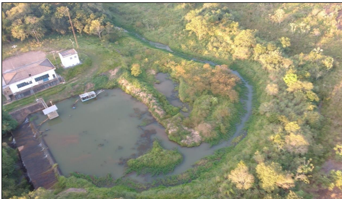
Figura 26. Vista aérea da Estação de Captação de Água da Sabesp.
