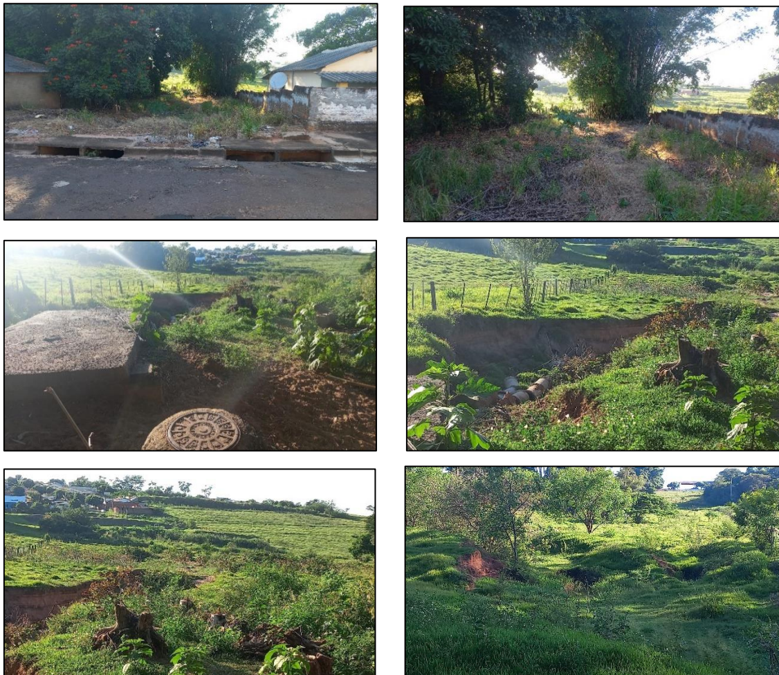
Figura 47 (A, B, C, D, E e F). Escoamento de água de chuva em área urbana gerando erosões em propriedade rural.
