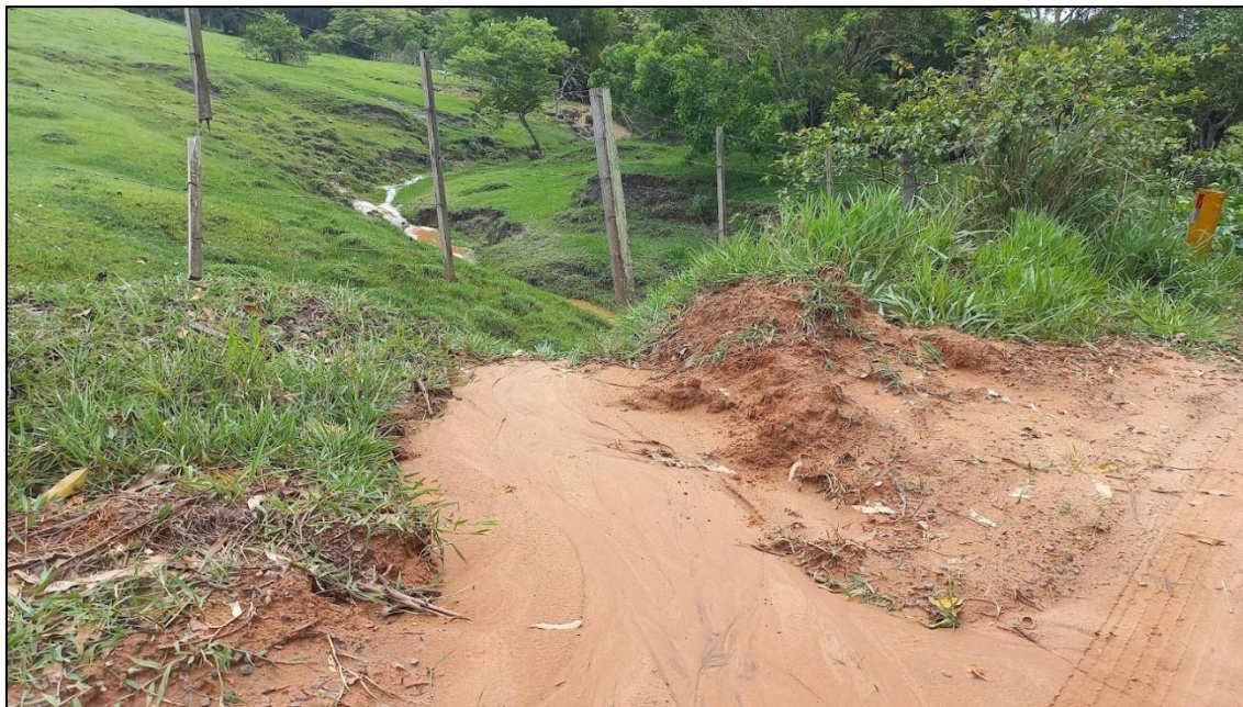
Figura 53. Problemas de conservação de estrada rural gerando transporte de sedimentos para afluente do Ribeirão Negrinha.
