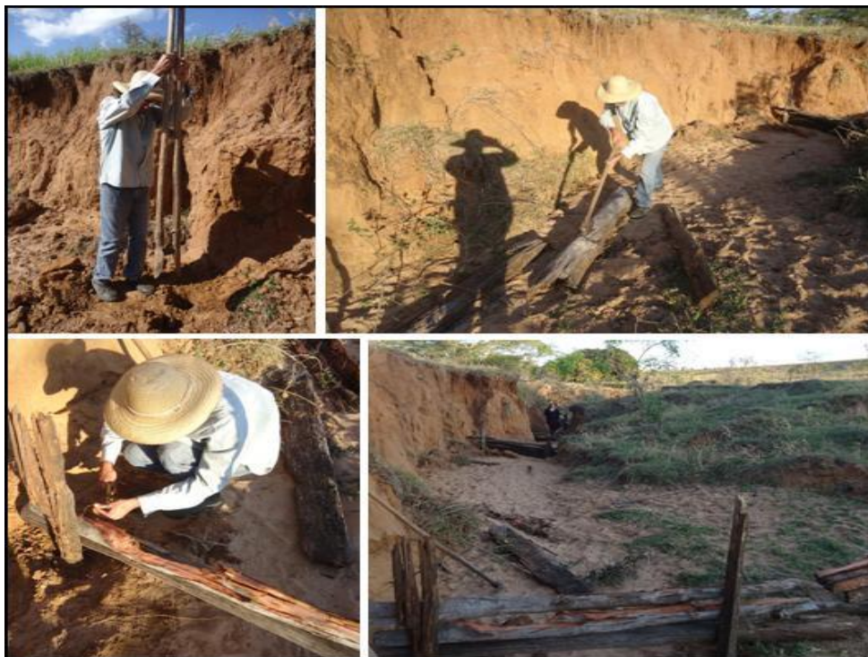
Figura 28: Construção das paliçadas: sítio “São José”, Regente Feijó/SP, 2016.
