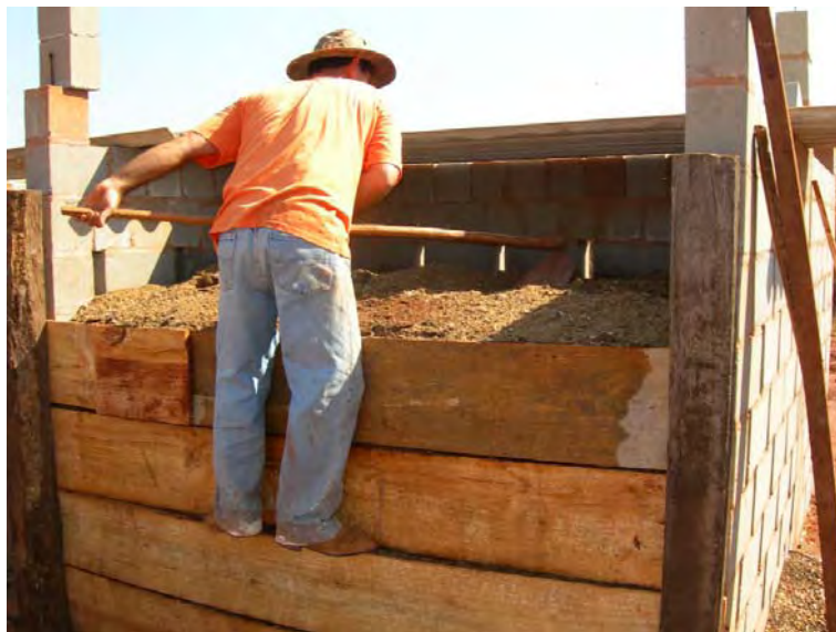
Figura 1: Colocação da ultima camada de cama, de aproximadamente 30cm – camada dupla.
