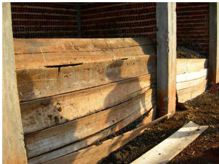
Figura 4: Granja no município de Ubarana - células de 2m de comprimento por 3m de largura - envergadura das tabuas
