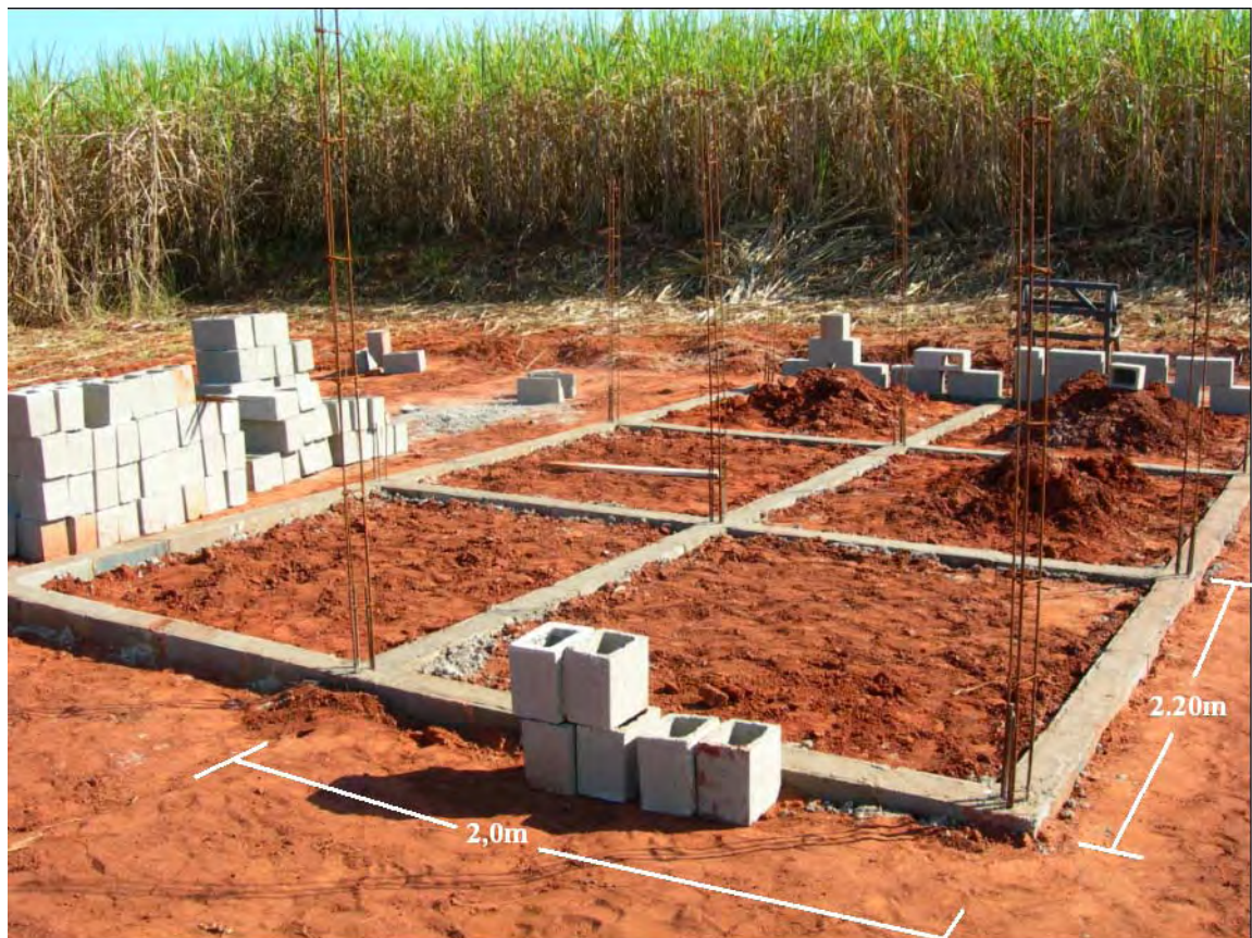
Figura 6: Dimensões da composteira de 2,00 m de comprimento por 2.20m de largura
