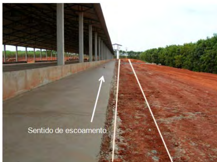
Ilustração 8: Localização de onde serão instalados os canais de drenagem ao longo da granja.
