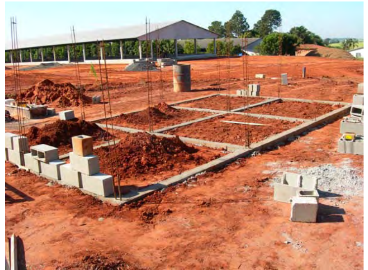
Figura 5: Alicerce já iniciado da composteira
