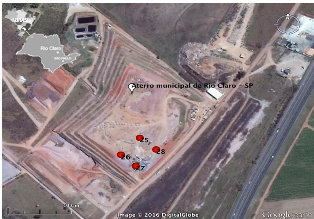
Figura 7: Localização dos drenos de gás no aterro sanitário de Rio Claro (SP) Fonte: Google Earth (modificado)
