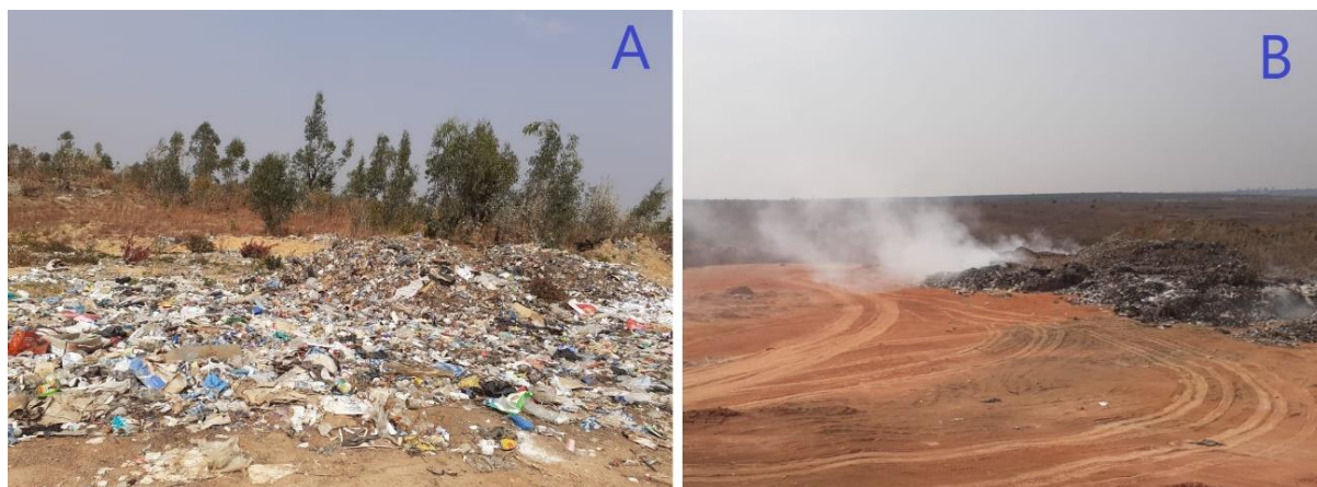
Figura 6. Aterro controlado de Kuito: (A) resíduos sólidos expostos a céu aberto; (B) queima espontânea dos resíduos sólidos
