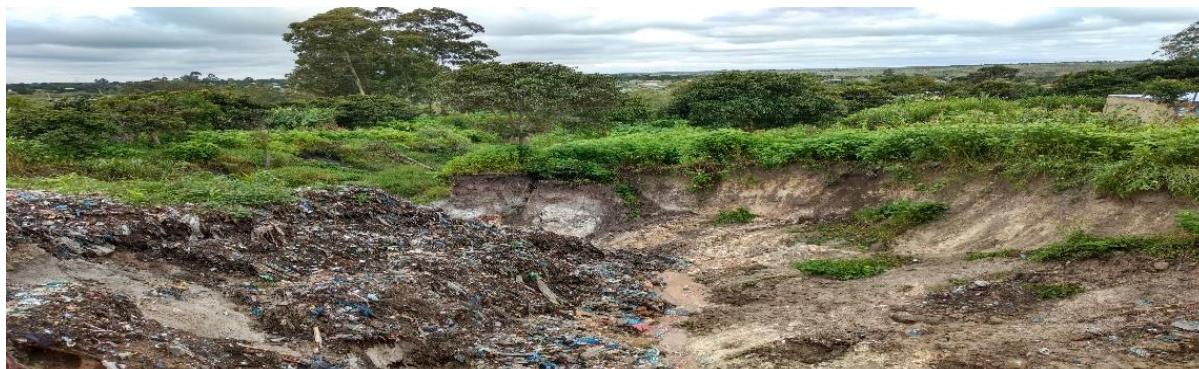
Figura 5. Vista da área de disposição dos RSU de Kuito, Província do Bié, região central de Angola.
