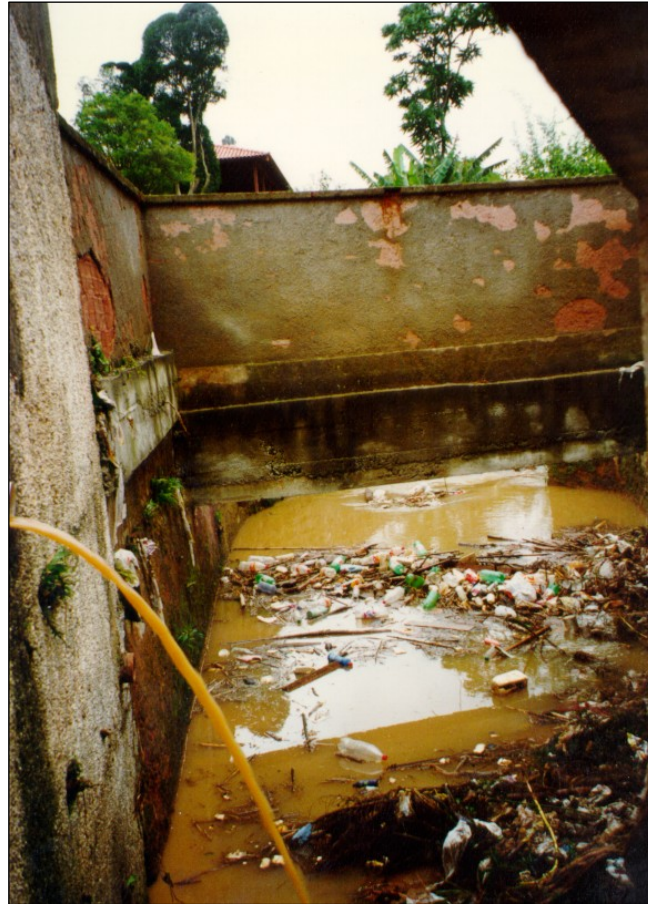
Foto 3: Trecho do rio Meudon afluente do rio Paquequer
