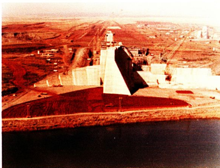
Figura 1 – Vista de barragem de gravidade da UHE Três Irmãos.
