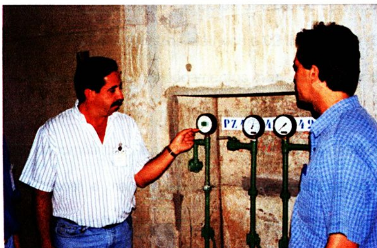
Figura 11 – Detalhe de inspeção técnica em galeria de barragem.
