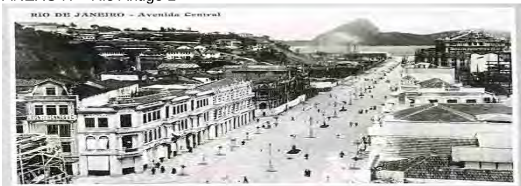
Foto 3 – Avenida Central. Fonte: Almacarioca
