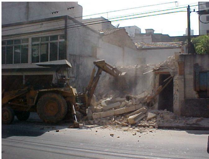
**Figura 3.1** – Demolição de residência com retroescavadeira
