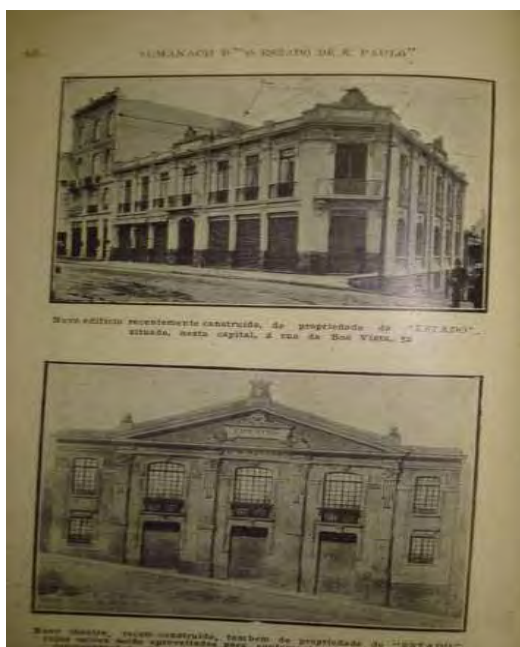
Fig. 21. No alto, o prédio do Estado da Rua Boa Vista e baixo o Teatro construído por Julio Mesquita. (IEB/USP)
