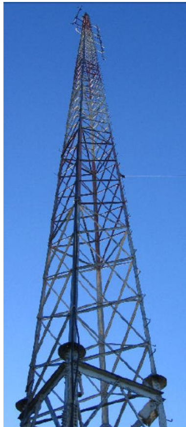
FIGURA 2.1 – Torre de Transmissão da Estação NDB
