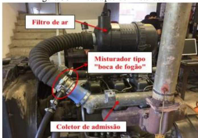
Figura 38 – Instalação do misturador
