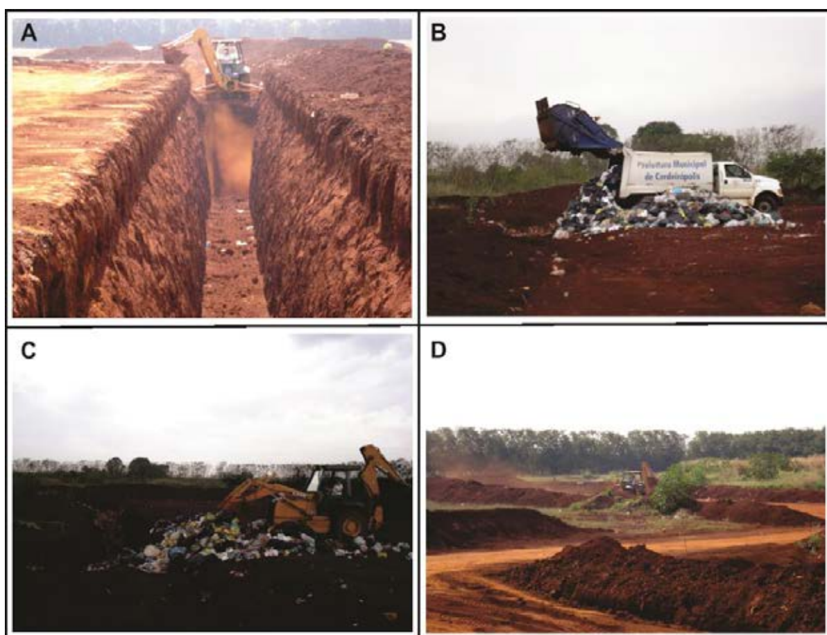
Figura 3 - Etapas de operação do aterro. (A) Abertura de vala; (B) Descarga de resíduos; (C) Lançamento e cobertura dos resíduos; (D) Valas finalizadas. Fonte: Adaptado de Moreira et al. (2011).
