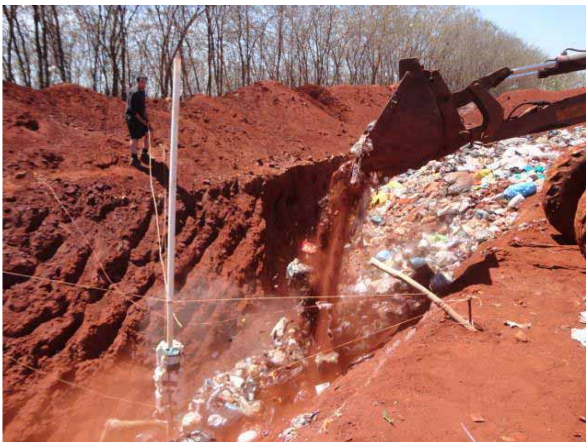
Figura 7 – Despejo cuidadoso dos resíduos para não afetar o tubo de PVC e o cabo com sensores. Fonte: Autor.
