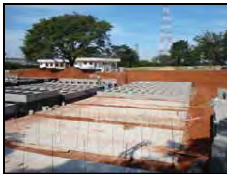
Figura 33 – Construção das Paredes com Blocos de Concreto
