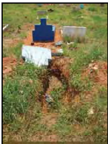
Figura 54 – Cemitério Redentor - Bauru Processo erosivo no jazigo
