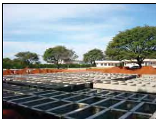
Figura 35 – Construção da Quadra
