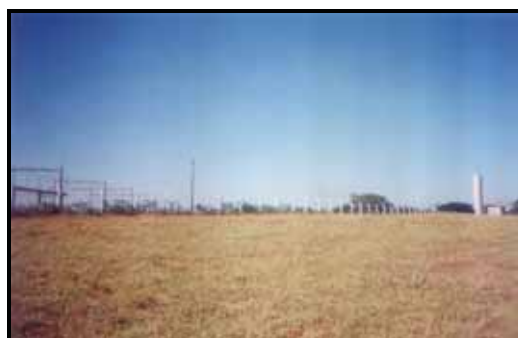
Figura 07 – Área Leste – Antiga Estação CESP
