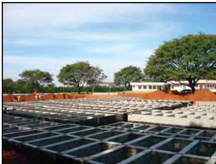
Figura 39 – Construção da primeira quadra do sepultamento
