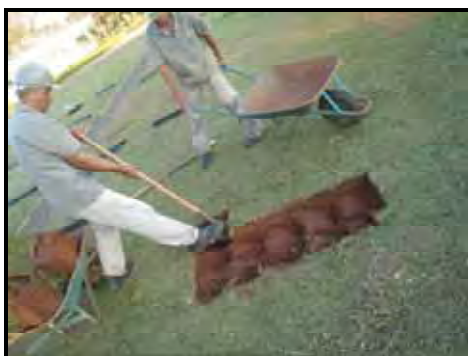
Figura 40 – Remoção de Terra para Preparação do Jazigo
