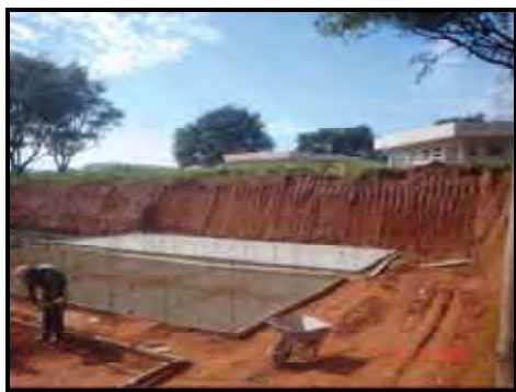
Figura 32 - Base dos Jazigos com concreto/Ferragens
