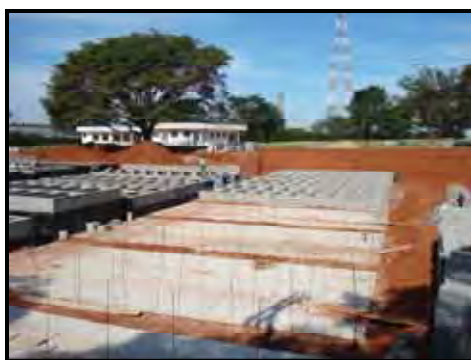
Figura 36 – Construção dos Jazigos
