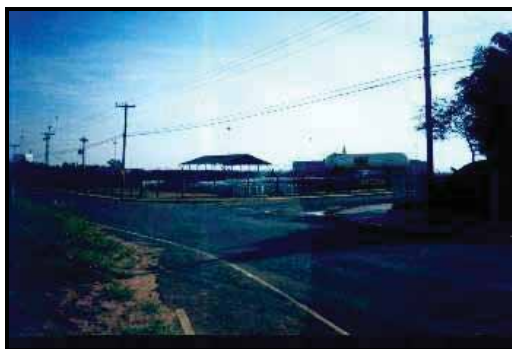
Figura 24 – Vista parcial externa da empresa Liquidigás
