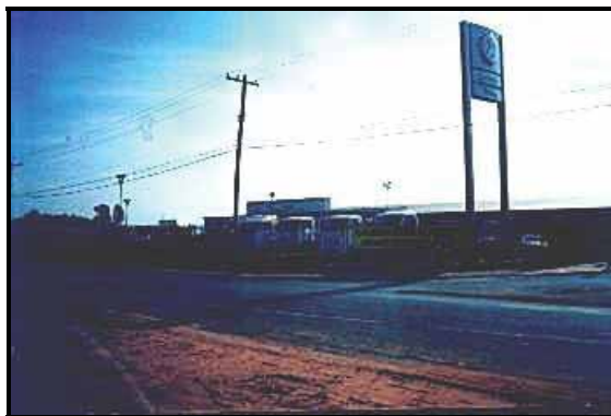
Figura 25 – Vista parcial externa da empresa Volkswagen Caminhões
