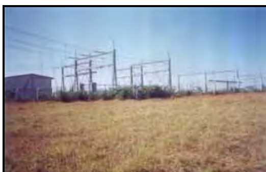
Figura 06 – Área Leste – Antiga Estação CESP
