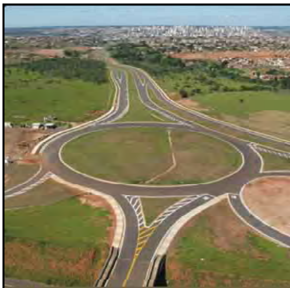
Figura 20 – Acesso da Rodovia SP 294 a Nações Norte
