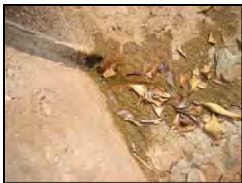
Figura 52 – Cemitério Jacuba – derramamento de líquido viscoso
