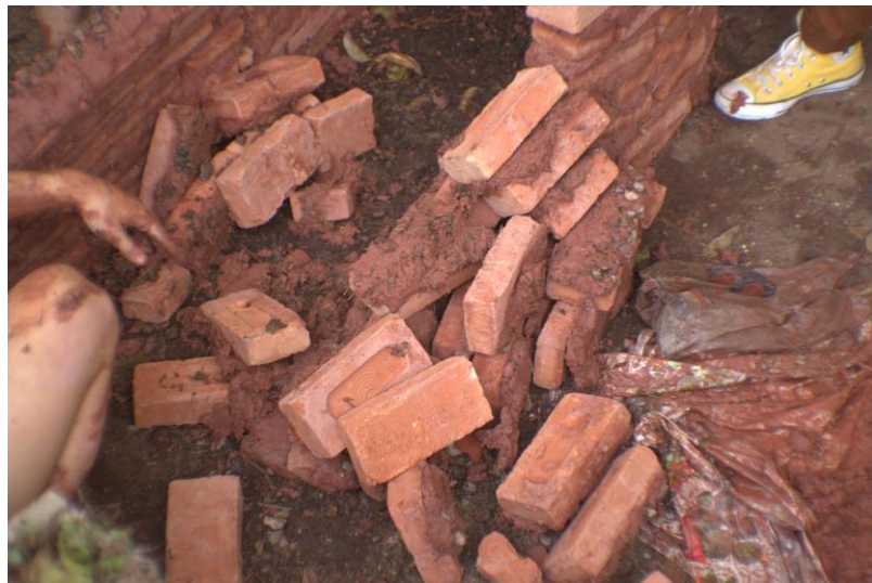
Figura 63 - Boca desmoronada.
