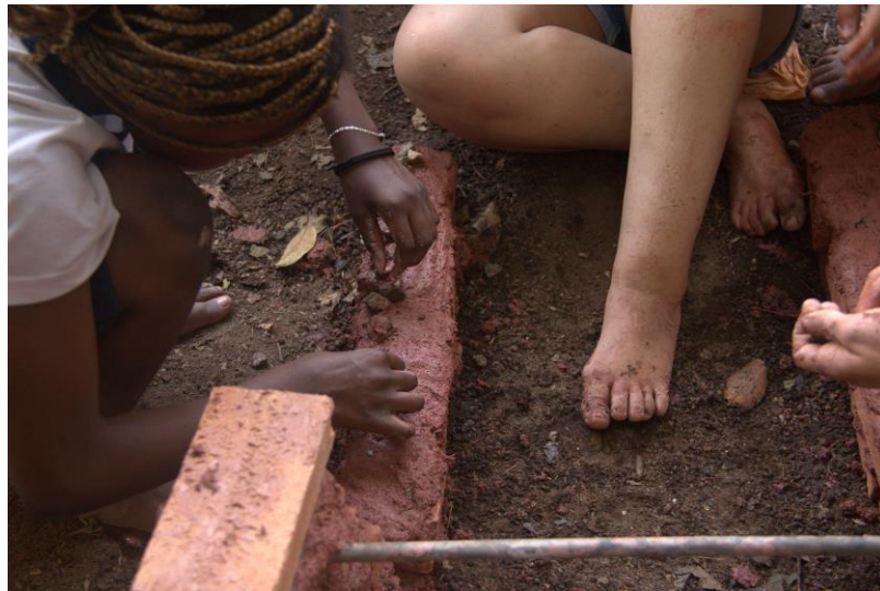
Figura 62 - Montagem da boca do forno.
