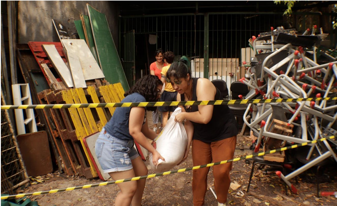
Figura 54 - Carregando terra para construção do forno
