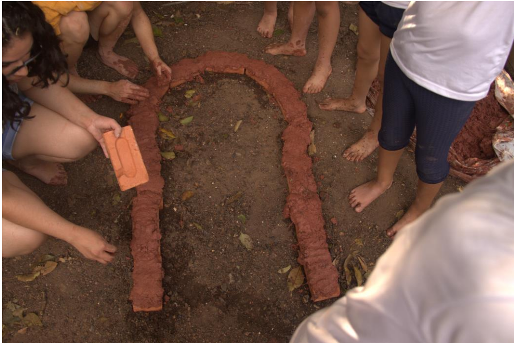
Figura 60 - Primeira camada de adobe colocada pelos estudantes.
