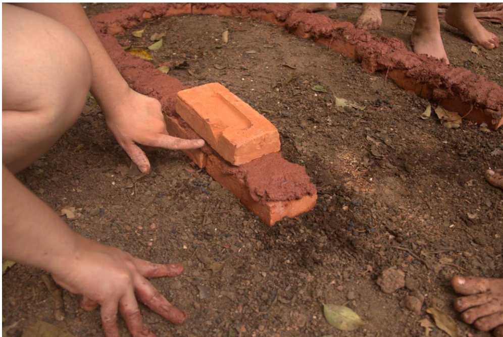
Figura 61 - Explicação sobre cruzar os tijolos.
