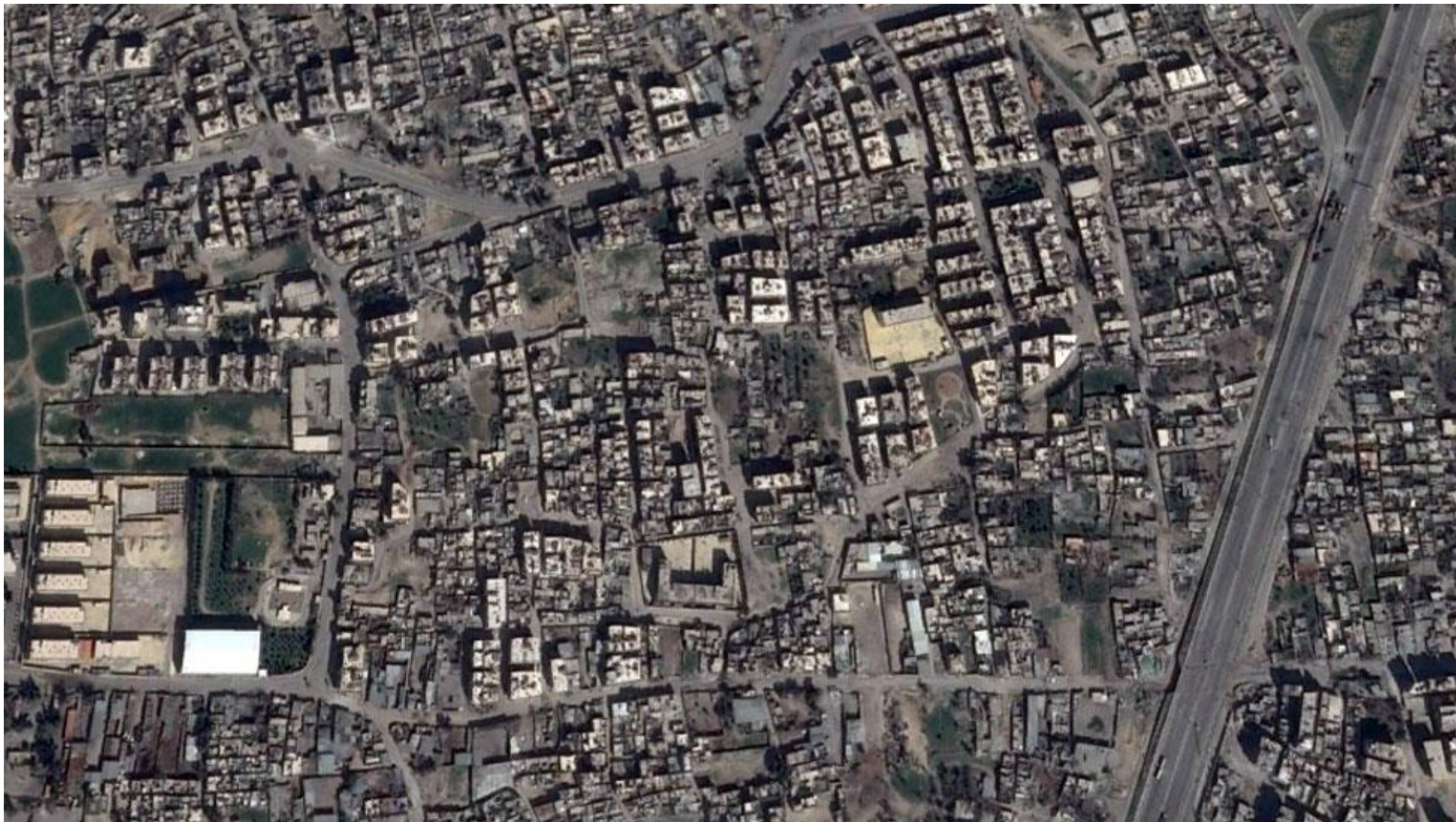
Figura 8 – Rede de trincheiras construídas em Jobar, de fevereiro de 2018.
