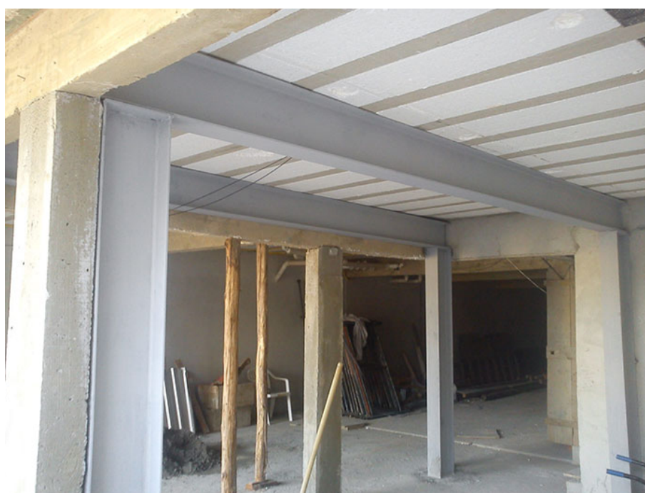
Figura 11 – Reforço com Perfil Metálico
