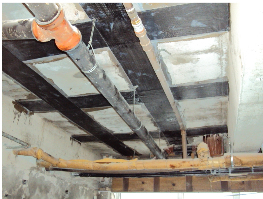
Figura 12 – Reforço com Manta de Fibra de Carbono
