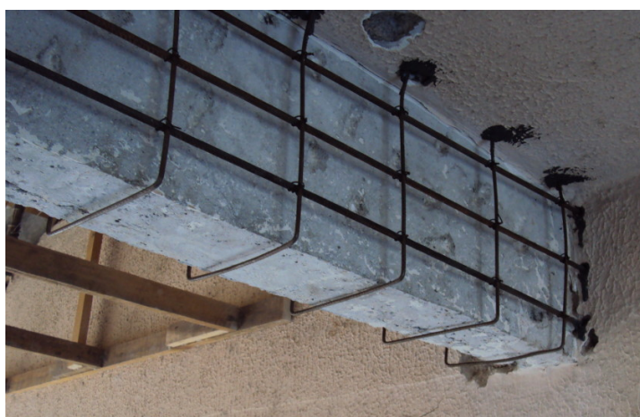
Figura 10 – Reforço com Aumento da Seção
