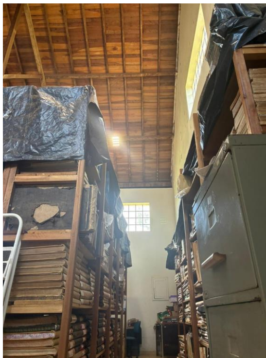
Figura 13 – Cobertura, grandes janelas e pé direito elevado.
