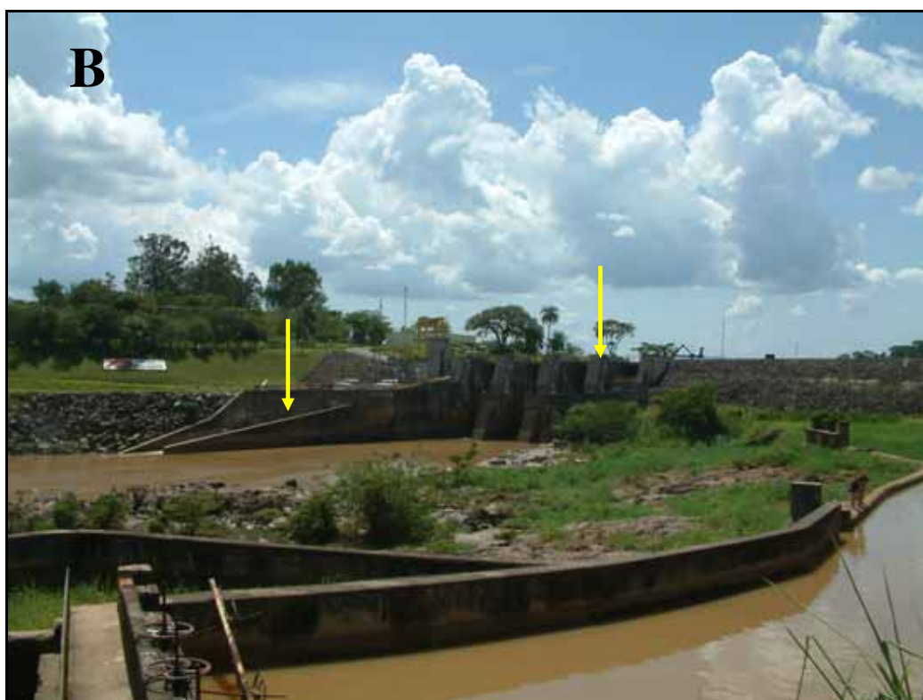
Figura 1: Usina Mogi Guaçu. Setas: (a) barragem, (b) escada de peixe (esquerda) e comportas (direita).
