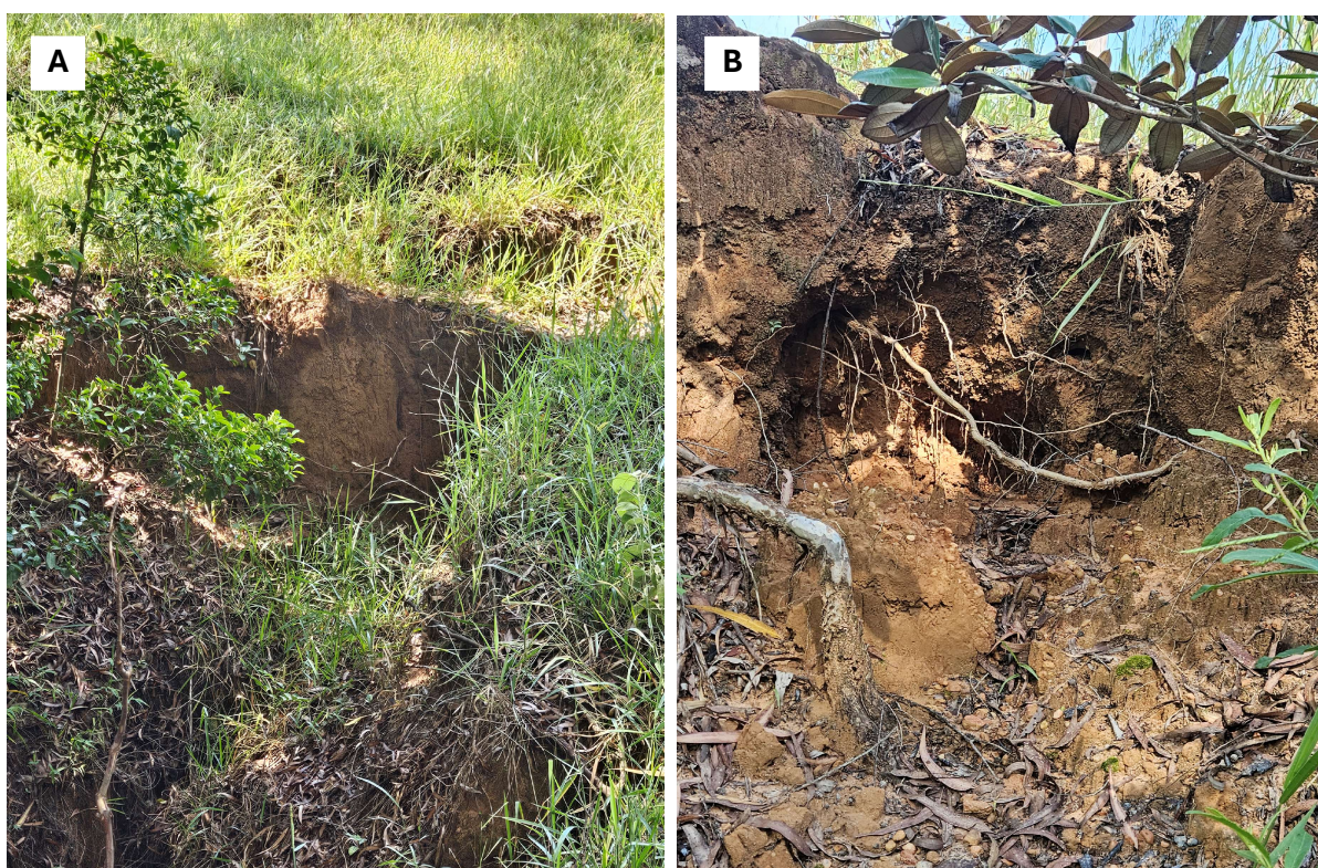
Figura 26. (A) Alcova de regressão localizada no interior da voçoroca (B) Processo de solapamento identificado no interior da voçoroca.
