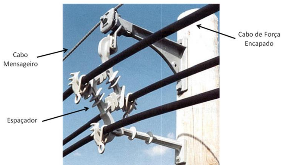
Figura 3.4 – Rede compacta com braço tipo L.
