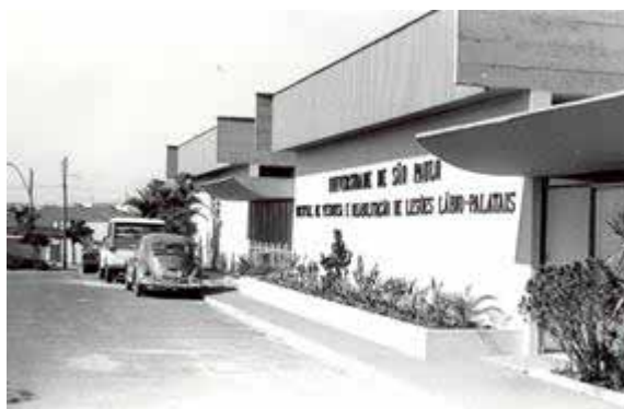
Detalhe para fachada em 1973 do HRAC – Hospital de Reabilitação de Anomalias Craniofaciais (Centrinho) em Bauru – SP. Foto: Arquivo HRAC
