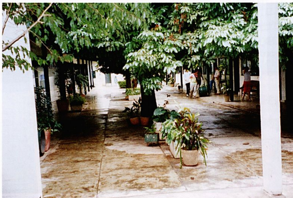
Figura 30 – Pátio interno de circulação entre as salas de aula da escola B.
