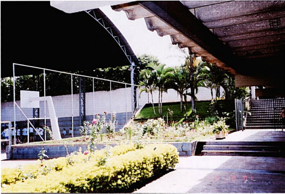
Figura 20 – Pátio interno de circulação entre a quadra poliesportiva, o setor administrativo e as salas de aula da escola A.
