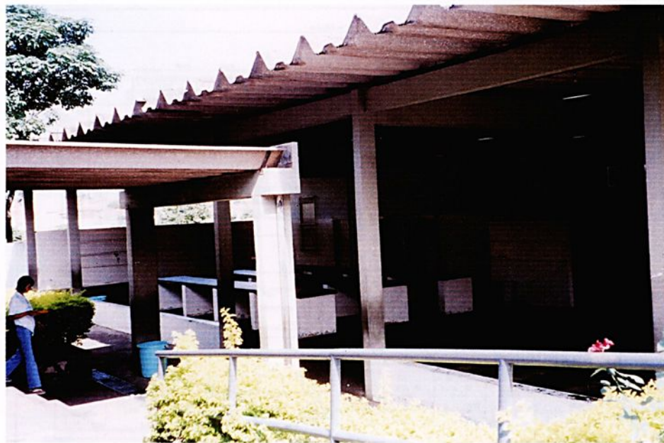
Figura 23 – Pátio interno para refeições, ligando salas de aula, biblioteca, bebedouros de água, banheiros, cozinha e cantina.
