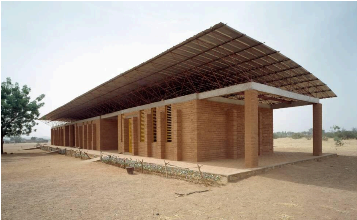
Figura 2 - Escola primária de Gando
