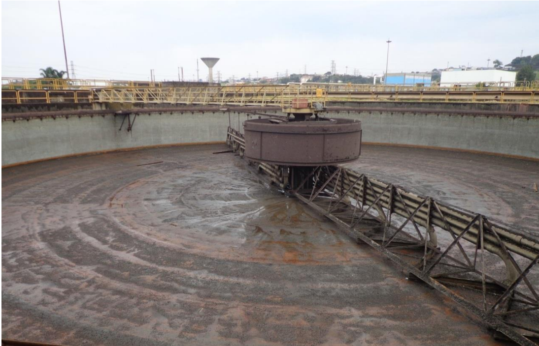
Figura 04 – Adensador na ETE Barueri
