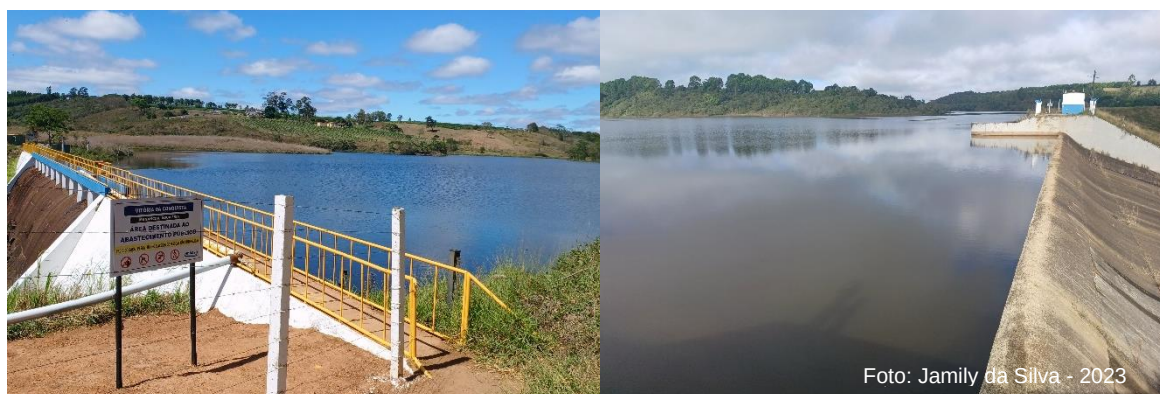
Figura 2 - Barragens Água Fria I e II, no município de Barra do Choça
